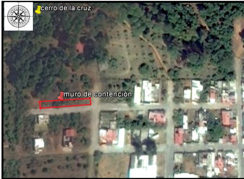
Figura: 3.4 Localización del terreno donde se pretende desplantar el muro de contención
