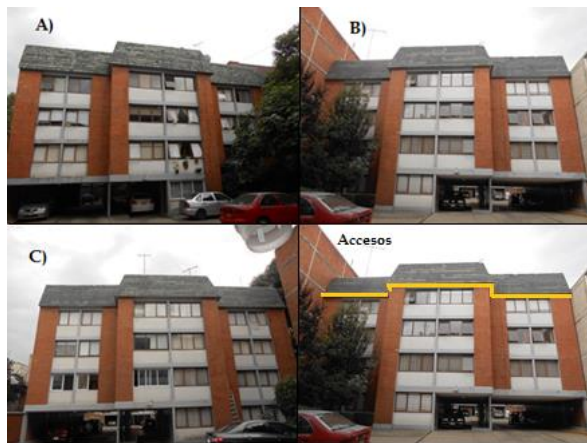
Figura 18.- A) Edificio A; B) Edificio B; C) Edificio C. La línea amarilla muestra los lugares de acceso con los que cuentan los murciélagos (Toma de foto del Edificio B). En la parte de abajo se muestra el volumen y forma del refugio. Fotos tomadas por Yezenia G. Bermúdez.
