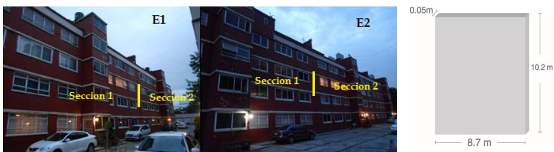
Figura 17.- Foto de los edificios E1 y E2, la línea amarilla muestra la división de los edificios en dos secciones (Junta constructiva). Esta separación es el acceso de los murciélagos al refugio. En la parte del lado izquierdo se muestra el volumen y forma del refugio. Fotos tomadas por Yezenia G. Bermúdez.
