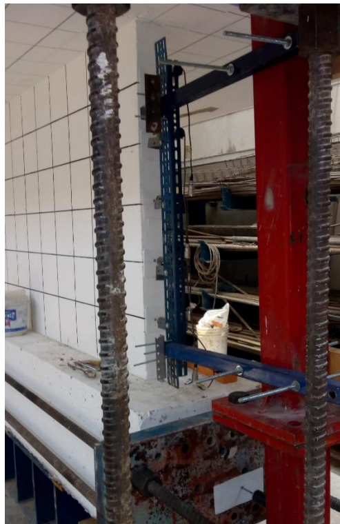
Figura 20. Instalación de LVDT en el muro inferior (Créditos: Juan Gómez)
