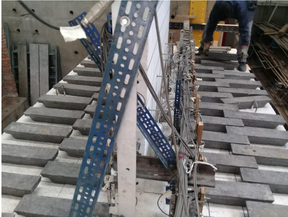
Figura 22. Colocación de los lingotes sobre la losa (Créditos: Eduardo Martínez)
