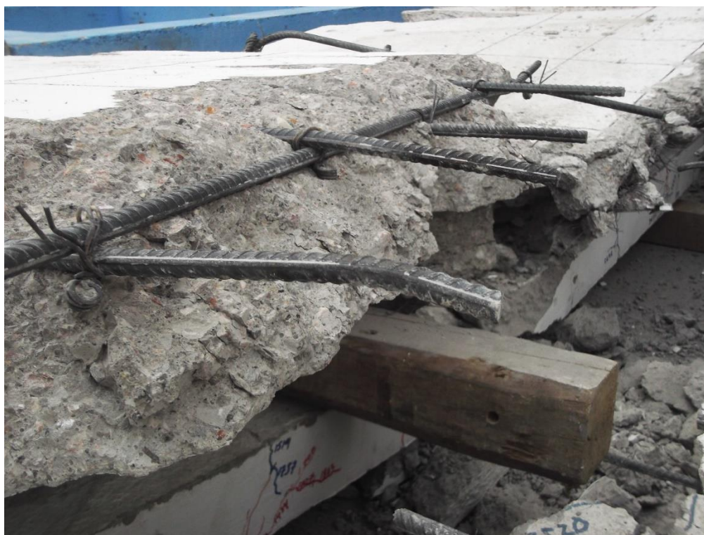
Figura 46. Colocación cuatrapeada del armado de la losa del espécimen Control
