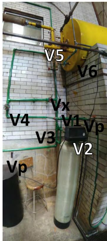
Figura 4.2 Distribución de las válvulas V1 a V5
