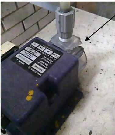
*Figura 3.11 Bomba Dosificadora dañada*
