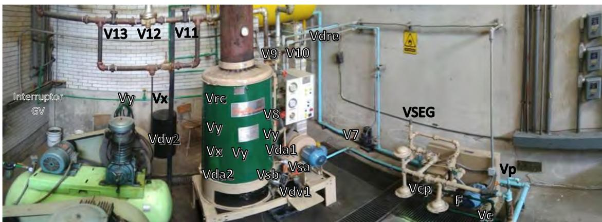
Figura 3.7 Distribución de las válvulas V5 a V13
