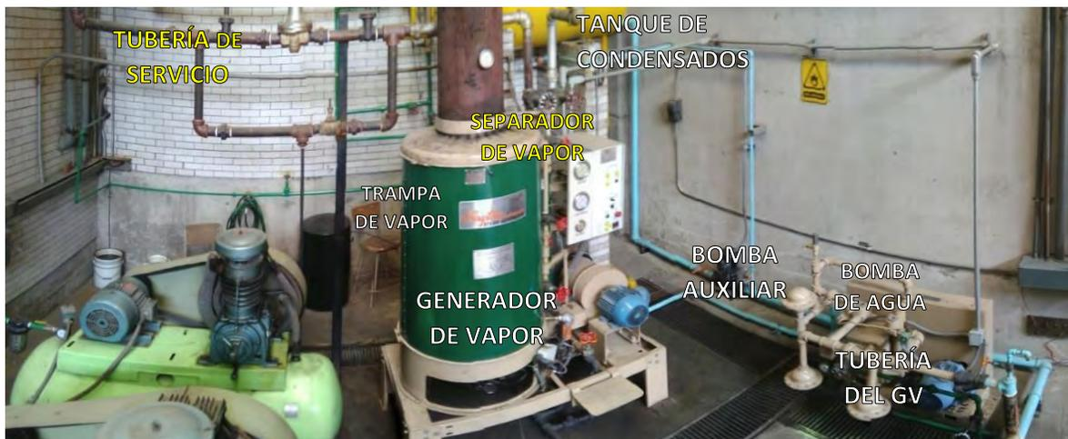
Figura 3.9 Distribución de los elementos para generación de vapor
