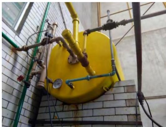
*Figura 3.12 Tanque de condensados*
