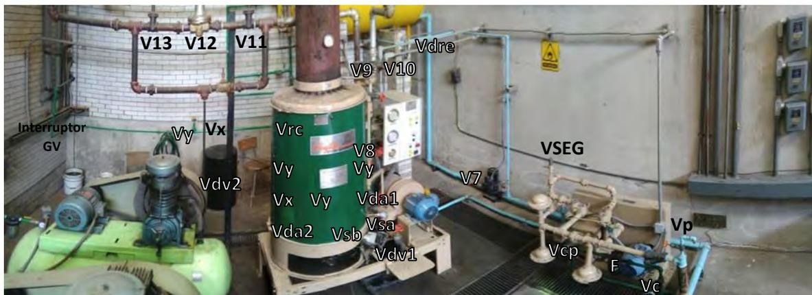
Figura 4.3 Distribución de las válvulas V5 a V13
