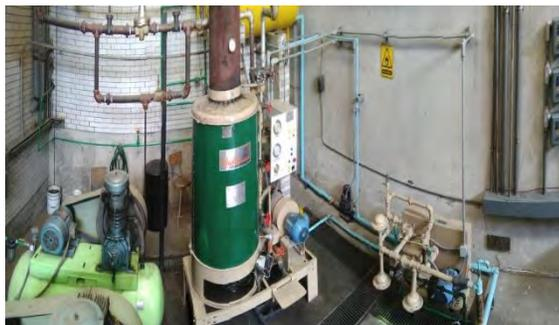
*Figura 3.13 Tubería del Generador de Vapor*
