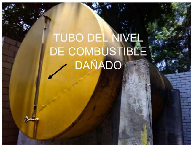
Figura 3.10 Tanque de combustible de 5,000 litros
