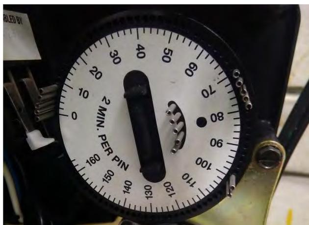
*Figura 3.17 Control de arranque con divisiones para la regeneración del Suavizador Automático*
