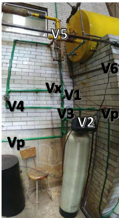
Figura 3.6 Distribución de las válvulas V1 a V5
