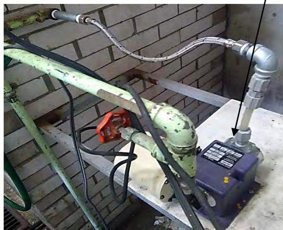
*Figura 3.12 Bomba Dosificadora reparada*
