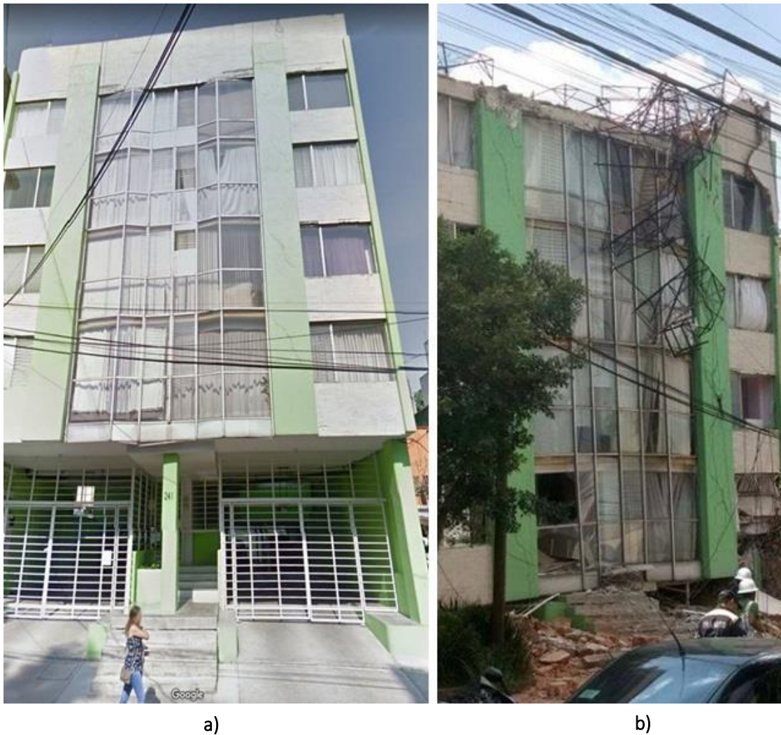
Figura A. 23 Edificio en Rébsamen No. 241: a) antes del evento sísmico y b) después del evento sísmico de M7.1 ( http://bit.do/d3u65 )
