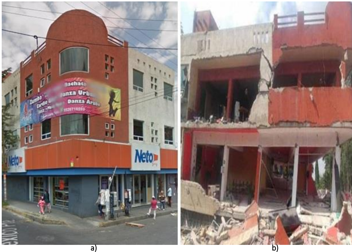
Figura A. 31 Edificio en Lázaro Cárdenas y Av. México: a) antes del evento sísmico y b) después del evento sísmico de M7.1 ( http://bit.ly/2nk4V0m )
