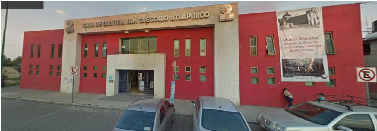
Figura B. 15 Edificación en Av. Cuauhtémoc No. 36: a) antes del evento sísmico de M7.1 (imagen obtenida de Google Maps)
