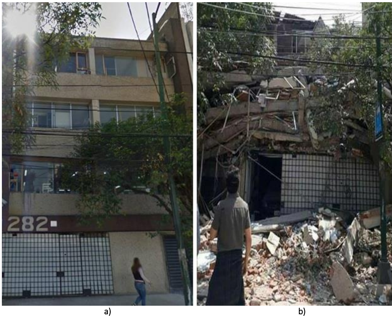
Figura A. 13 Edificio Puebla No. 282: a) antes del evento sísmico y b) después del evento sísmico de M7.1 ( http://bit.do/d3u65 )
