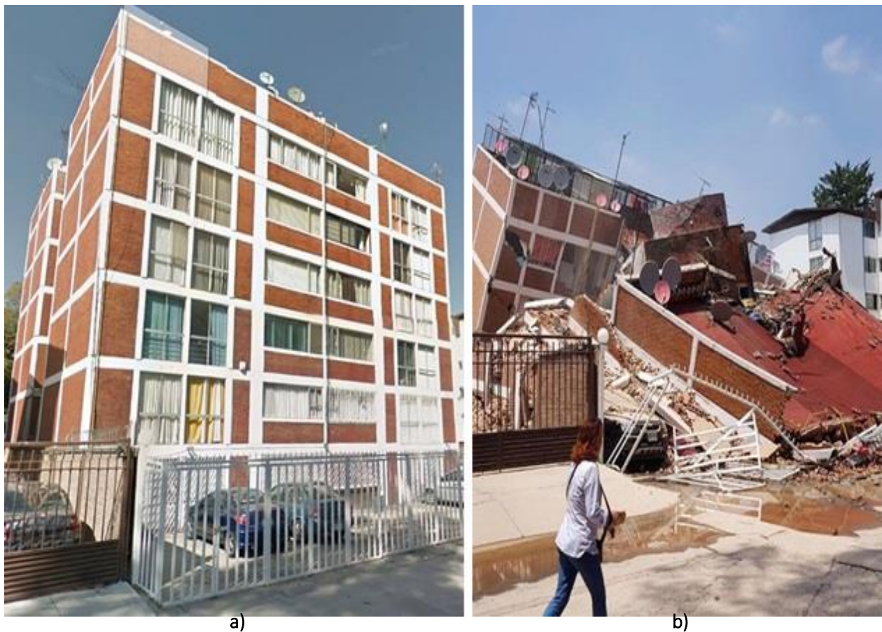
Figura A. 7 Edificio en Rancho Los Arcos No. 32: a) antes del evento sísmico y b) después del evento sísmico de M7.1 ( http://bit.do/d3u65 )
