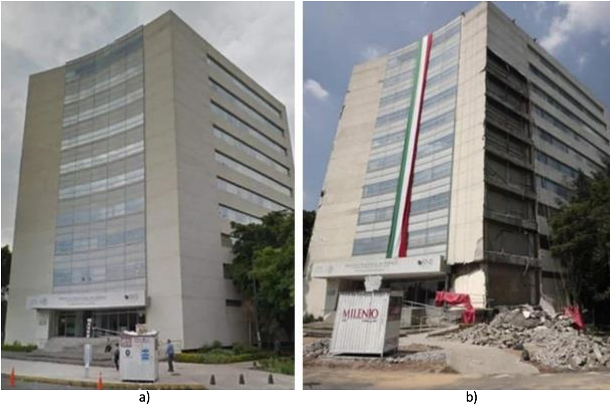
Figura B. 11 Edificio en San Antonio Av. Cuauhtémoc: a) antes del evento sísmico y b) después del evento sísmico de M7.1( http://bit.ly/2BzABUJ ).
