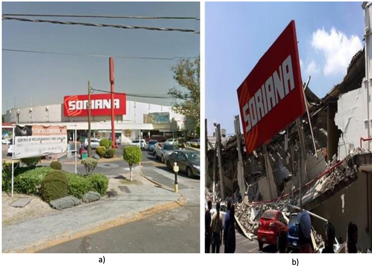
Figura A. 22 Edificio en Calzada de Taxqueña: a) antes del evento sísmico y b) después del evento sísmico de M7.1 ( http://bit.do/d3u65 )
