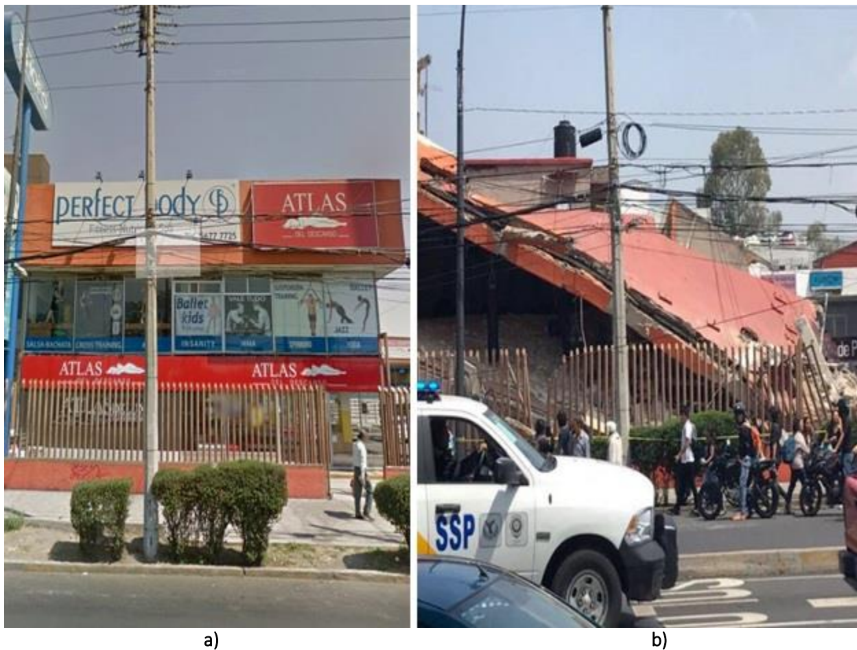
Figura A. 26 Edificio en Calzada del Hueso No. 480: a) antes del evento sísmico y b) después del evento sísmico de M7.1 ( http://bit.do/d3u65 )
