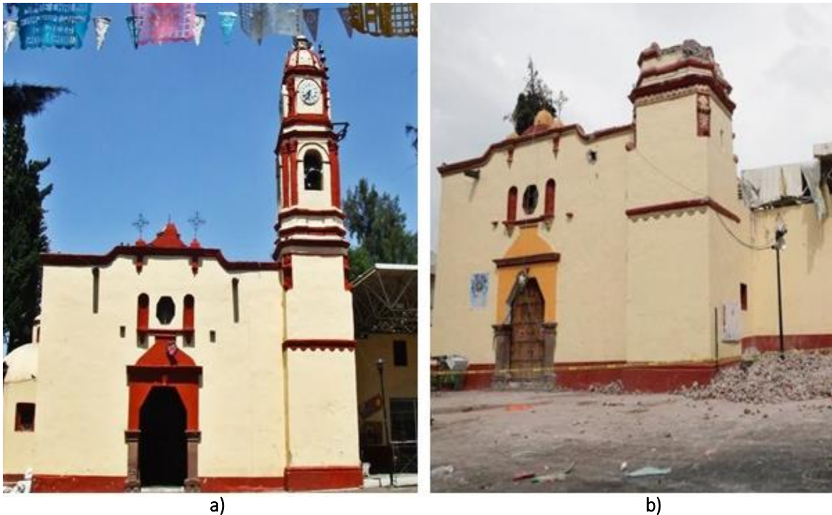
Figura B. 12 Iglesia en San Antonio Av. Cuauhtémoc: a) antes del evento sísmico y b) después del evento sísmico de M7.1 ( http://eluni.mx/2y1IO6H ).
