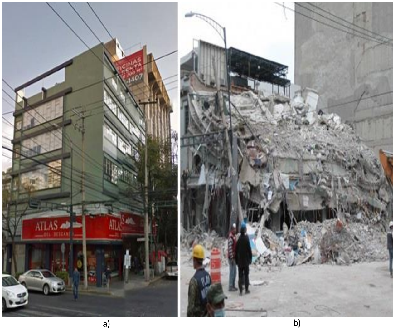
Figura A. 14 Edificio Medellín y San Luis: a) antes del evento sísmico y b) después del evento sísmico de M7.1 ( http://bit.do/d3u65 )
