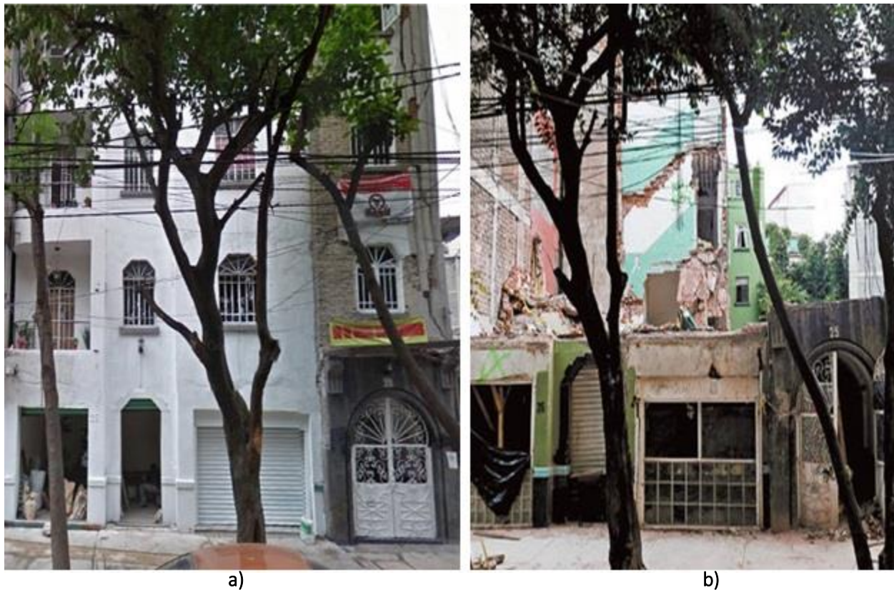
Figura A. 25 Edificio en Ámsterdam No. 25: a) antes del evento sísmico y b) después del evento sísmico de M7.1 ( http://bit.do/d3u65 )
