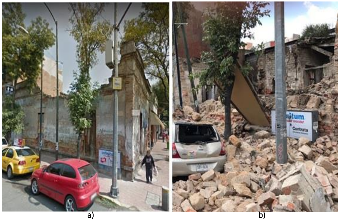
Figura A. 37 Edificio en Sabino esquina Díaz Mirón: a) antes del evento sísmico y b) después del evento sísmico de M7.1 ( http://bit.ly/2GenjRd )
