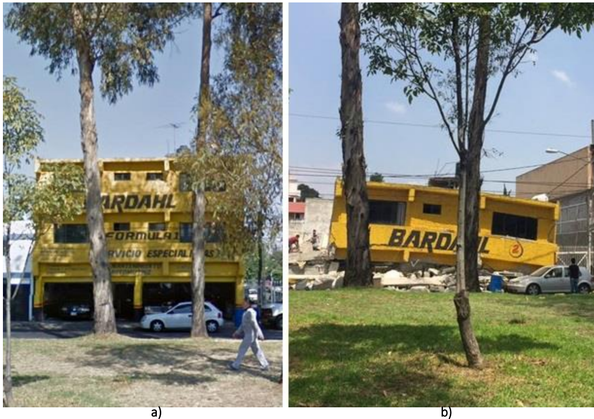
Figura A. 9 Edificio Santa Ana esq. Ejido Santa Cruz Atoyac: a) antes del evento sísmico y b) después del evento sísmico de M7.1 ( http://bit.do/d3u65 )
