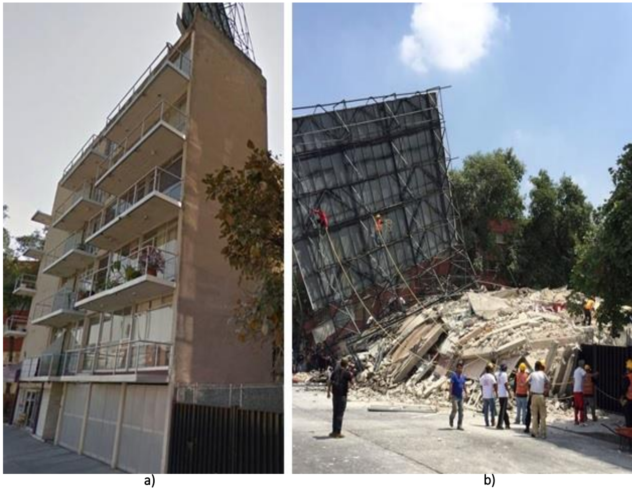
Figura A. 15 Edificio en Viaducto Miguel Alemán No. 106: a) antes del evento sísmico y b) después del evento sísmico de M7.1 ( http://bit.do/d3u65 )
