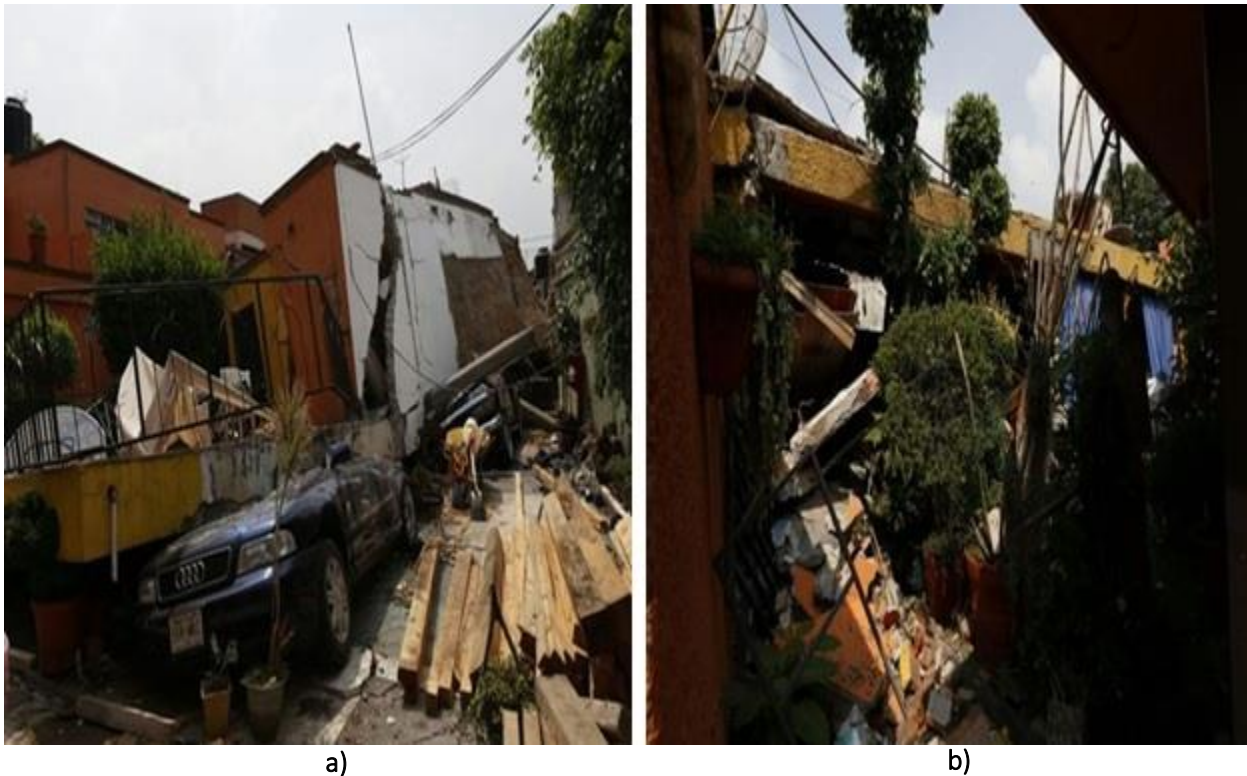
Figura A. 38 Edificio en Av. México Poniente No. 6, a) y b) los daños después del evento sísmico de M7.1 ( http://bit.ly/2nblQ3U )
