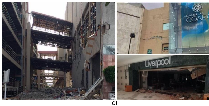
Figura B.3c Daños generados en la zona de Coapa después del evento sísmico de M7.2 ( http://bit.ly/2F19ft5 )
