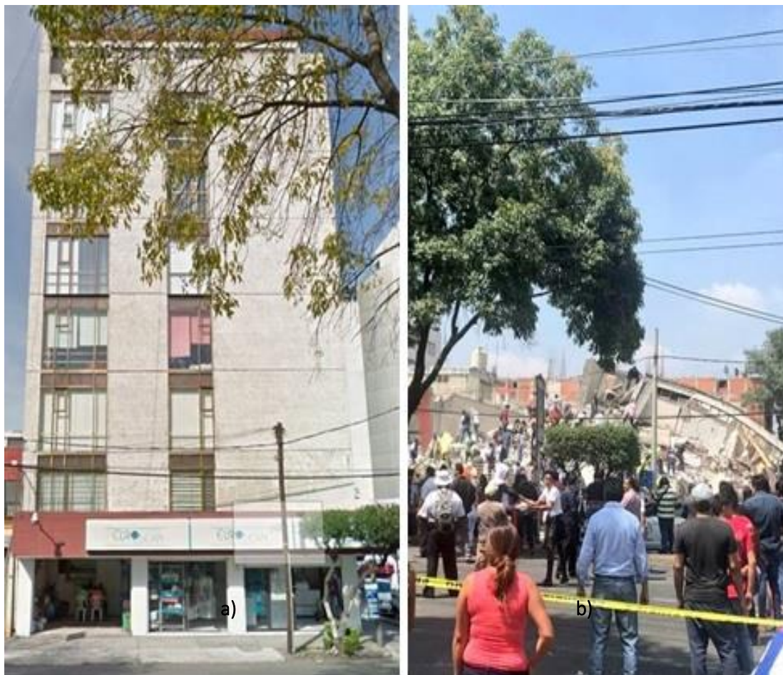
Figura A. 4 Edificio Prolongación Petén No. 915, esquina Zapata: a) antes del evento sísmico y b) después del evento sísmico de M7.1 ( http://bit.do/d3u65 )
