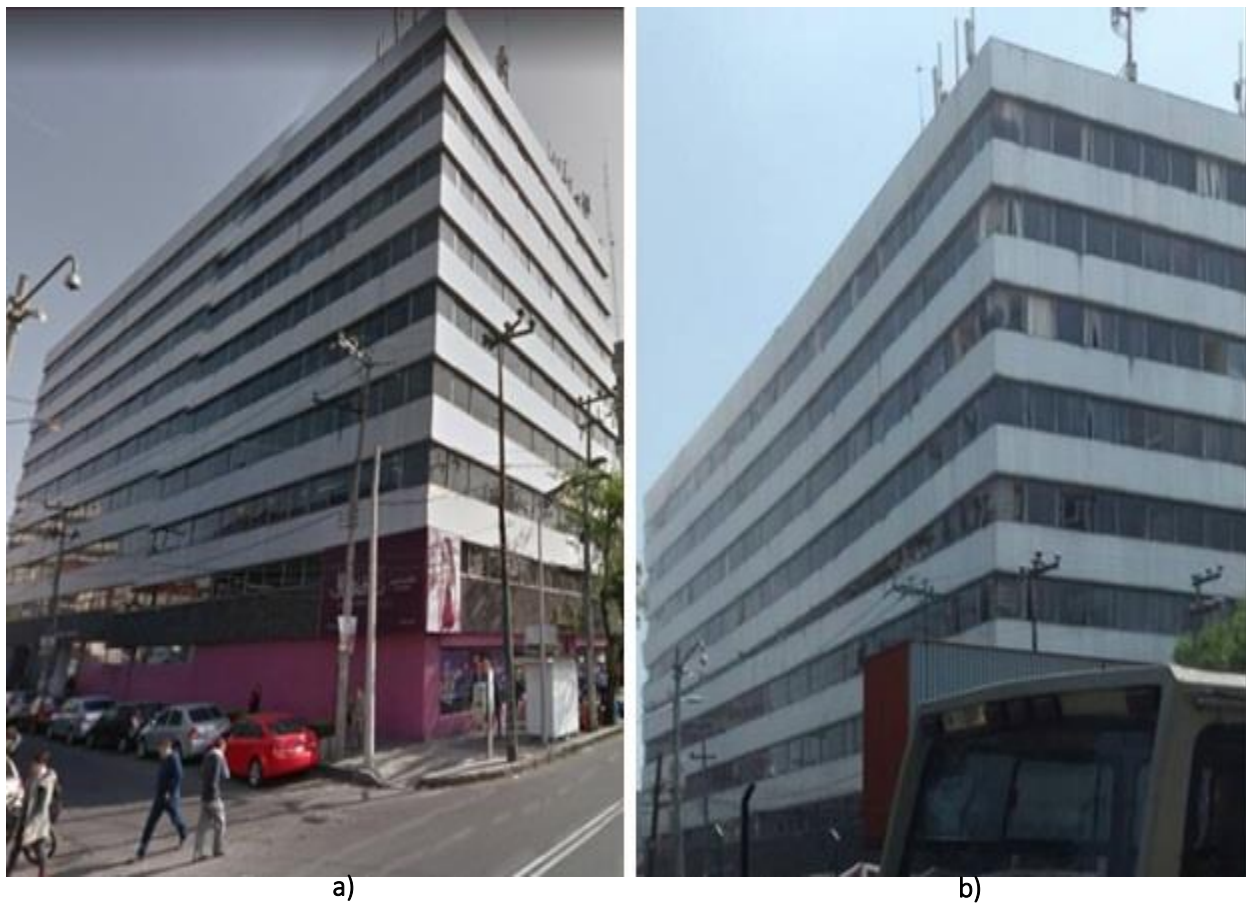
Figura A. 34 Edificio en San Antonio Abad No. 122: a) antes del evento sísmico y b) después del evento sísmico de M7.1 ( http://bit.ly/2DM5kE9 )
