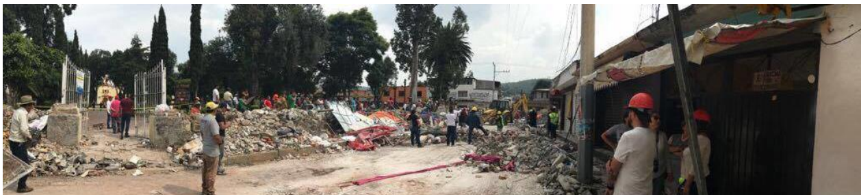
Figura B.12 Barda perteneciente a la iglesia de San Gregorio Atlapulco después del evento sísmico de M7.2 ( http://bit.ly/2wKBZ4B )
