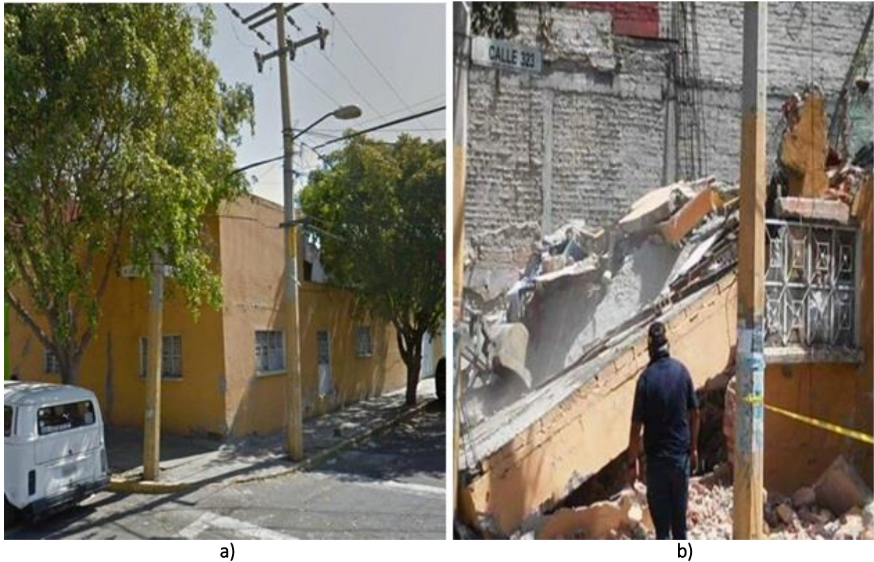
Figura A. 27 Edificio en Calle No. 323 esquina Calle No. 314: a) antes del evento sísmico y b) después del evento sísmico de M7.1 ( http://bit.do/d3u65 )
