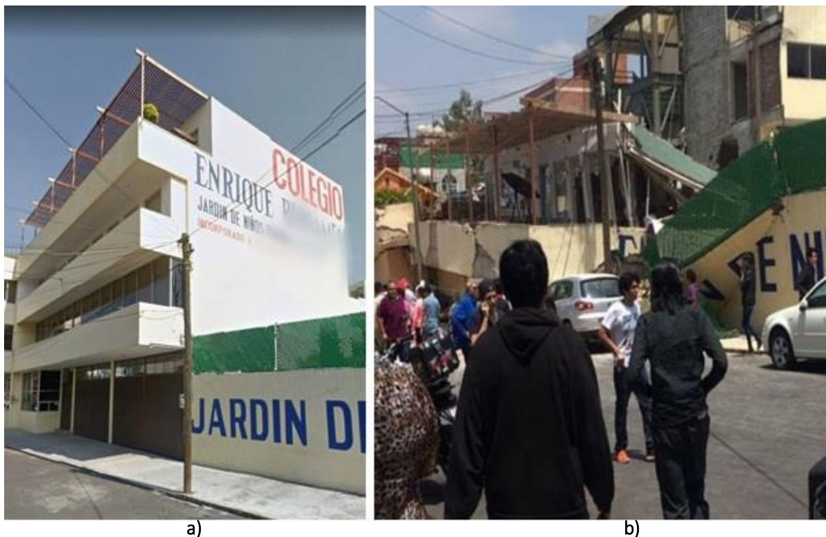
Figura A. 6 Edificio en Rancho Tamboreo esq. Calzada de las Escocia: a) antes del evento sísmico y b) después del evento sísmico M7.1 ( http://bit.do/d3u65 )
