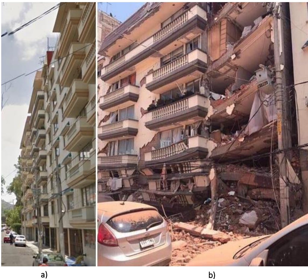
Figura A. 1 Edificio Coquimbo entre Sierra Vista y Ticomán: a) antes del evento sísmico y b) después del evento sísmico de M7.1. ( http://bit.do/d3u65 )
