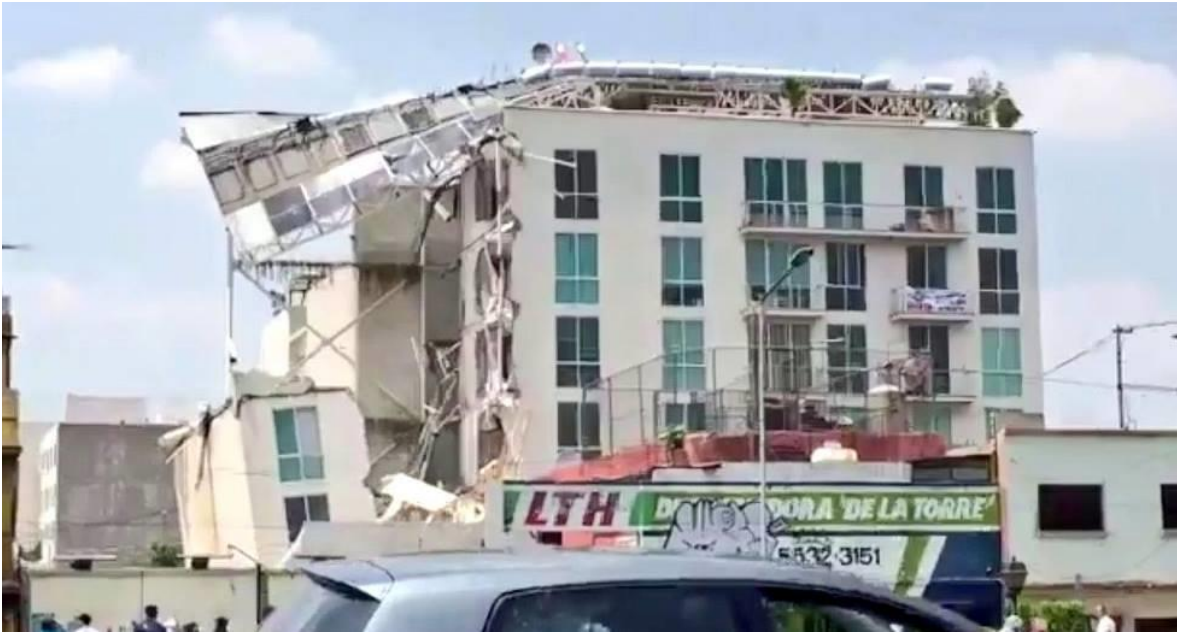
Figura 3.8 Edificio de uso vivienda de 6 pisos después del sismo ( http://bit.do/d3u65 ).
