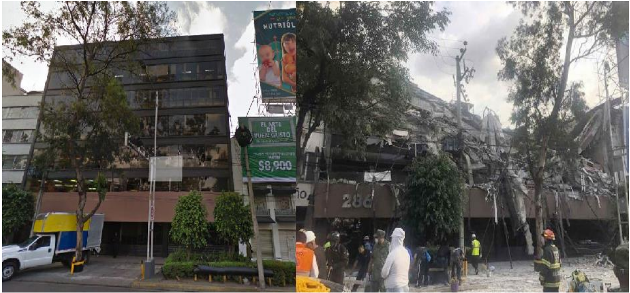
Figura 3.6 Edificio Álvaro obregón 286 antes y después del sismo de M7.1 del 19/09/2017 en la CDMX ( http:// bit.do/d3u65 )
