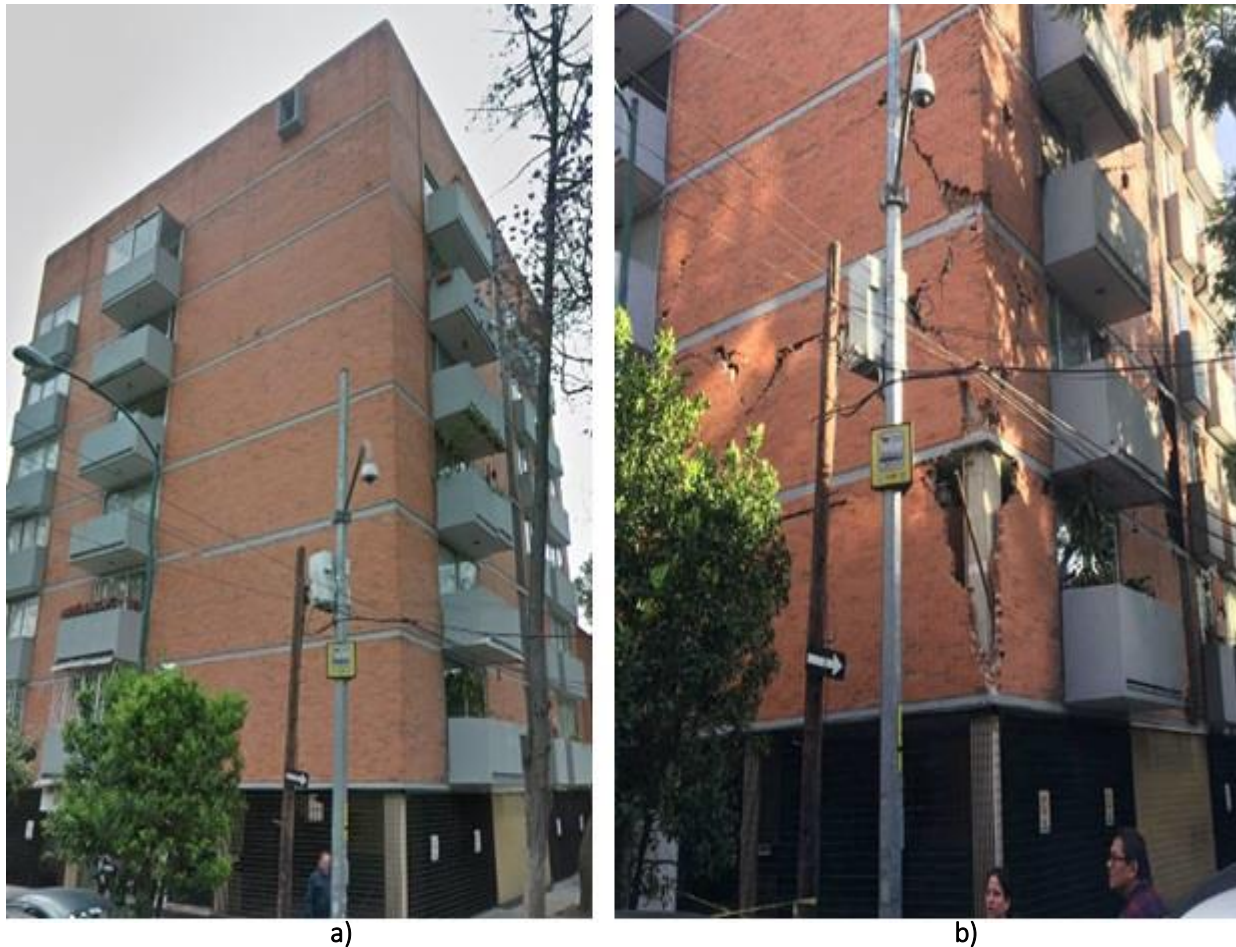
Figura B. 5 Edificio departamental en Amatlán y Montes de Oca: a) antes del evento sísmico y b) después del evento sísmico de M7.1 ( http://bit.ly/2FrePF5 )
