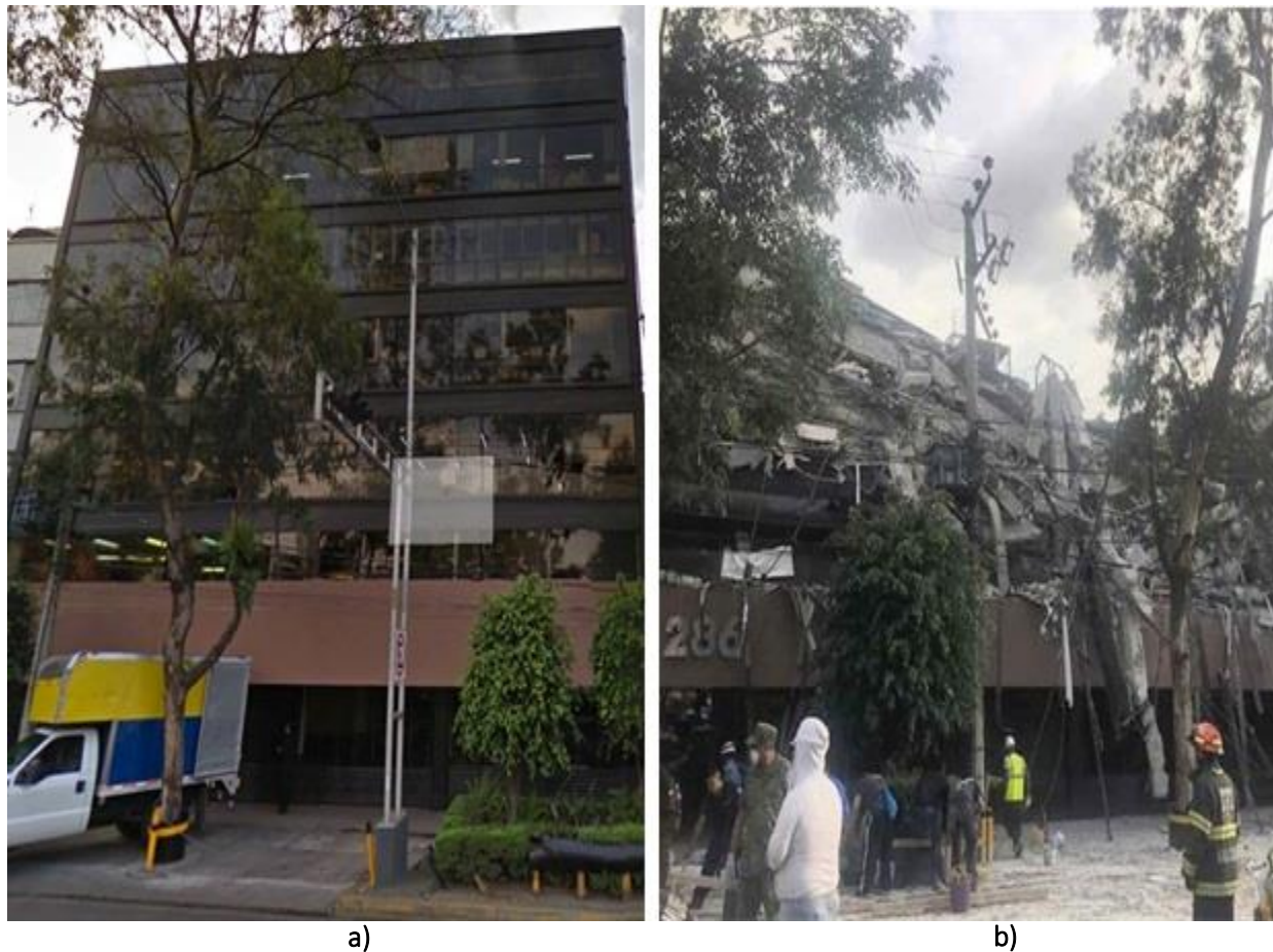
Figura A. 12 Edificio Álvaro Obregón No. 286: a) antes del evento sísmico y b) después del evento sísmico de M7.1 ( http://bit.do/d3u65 )
