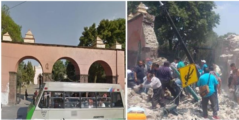
Figura B. 1 Arcos de la iglesia de San Bernardino de Siena en Lirio Acuático y Av. 16 de septiembre: a) antes del evento sísmico y b) después del evento sísmico de M7.1 ( http://bit.ly/2Ekahkc )
