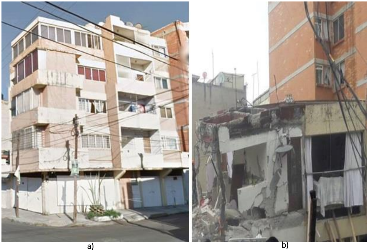
Figura A. 18 Edificio Niños Héroes No. 173, esquina Galicia: a) antes del evento sísmico y b) después del evento sísmico de M7.1 ( http://bit.do/d3u65 )
