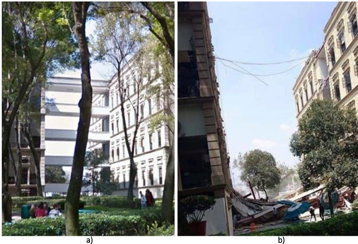
Figura B. 8 Edificio en Pról. Canal de Miramontes: a) antes del evento sísmico y b) después del evento sísmico de M7.1 ( http://bit.do/d3u65 )
