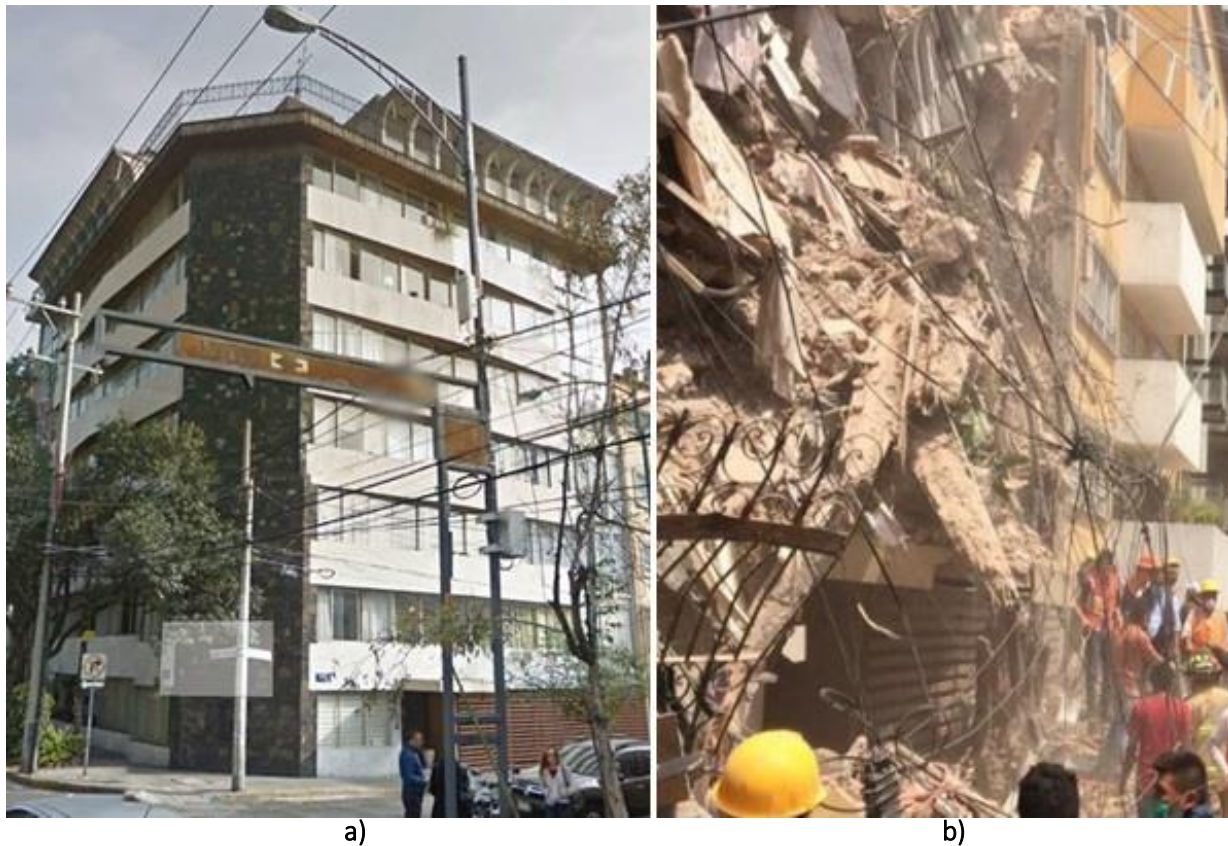
Figura A. 3 Edificio en Eje 2 poniente, Calle Gabriel Mancera y Escocia: a) antes del evento sísmico y b) después del evento sísmico de M7.1 ( http://bit.do/d3u65 )
