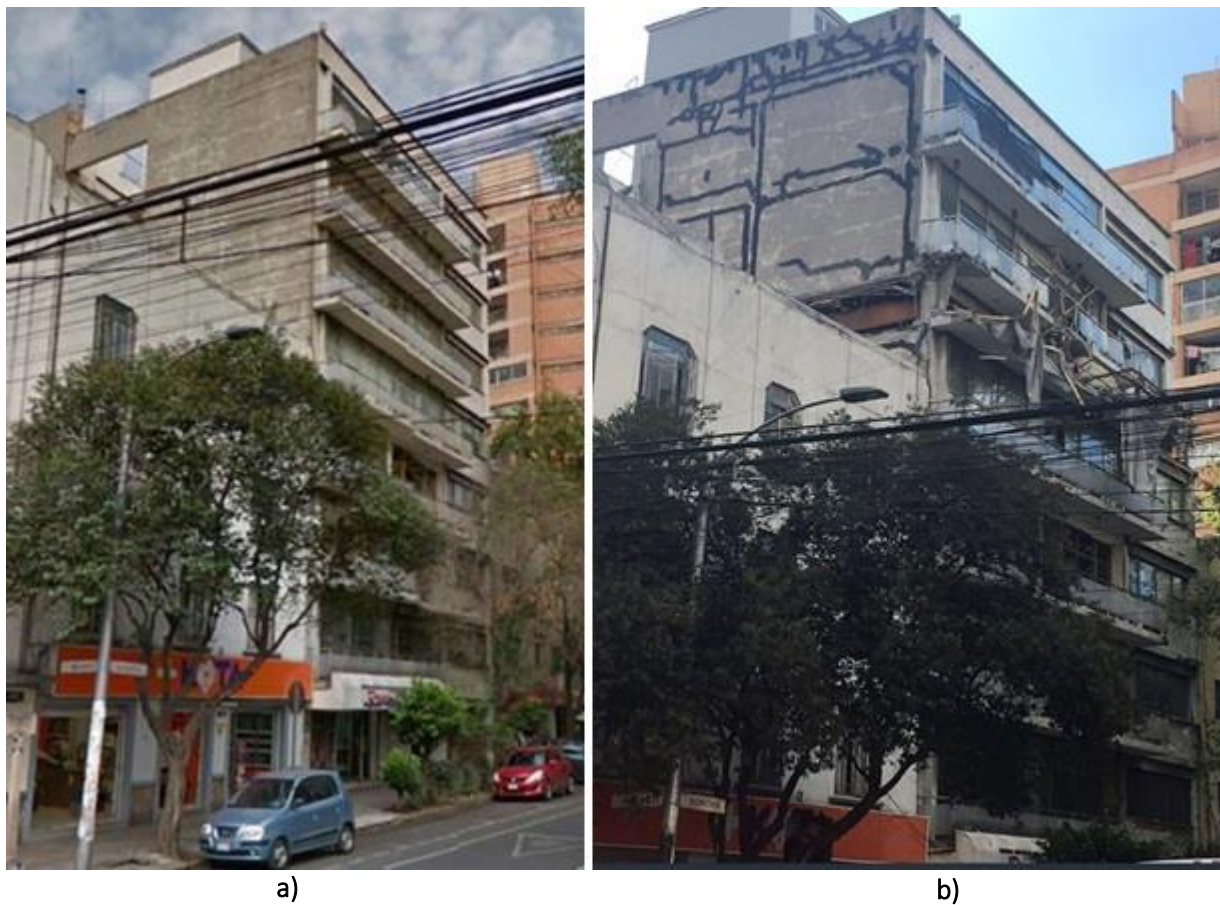
Figura A. 33 Edificio Sonora No. 149: a) antes del evento sísmico y b) después del evento sísmico de M7.1 ( http://bit.do/d3u65 )
