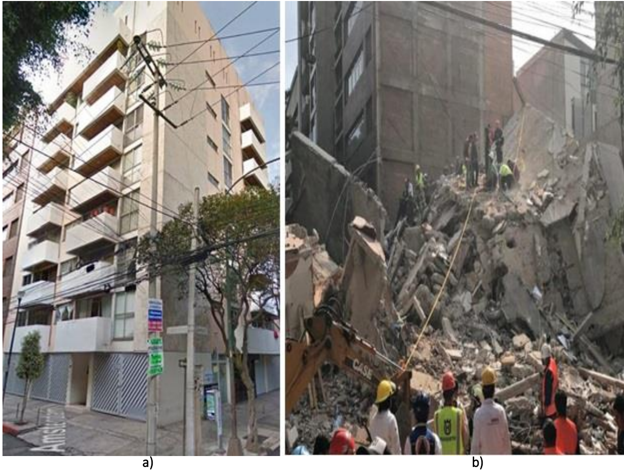
Figura A. 10 Edificio Ámsterdam No. 107: a) antes del evento sísmico y b) después del evento sísmico de M7.1 ( http://bit.do/d3u65 )
