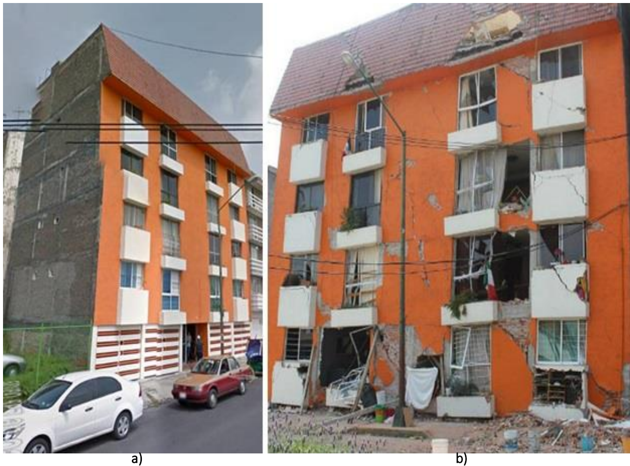
Figura A. 8 Edificio Paseo de las Galias No. 47: a) antes del evento sísmico y b) después del evento sísmico de M7.1 ( http://bit.do/d3u65 y http://bit.ly/2wDJxuv )
