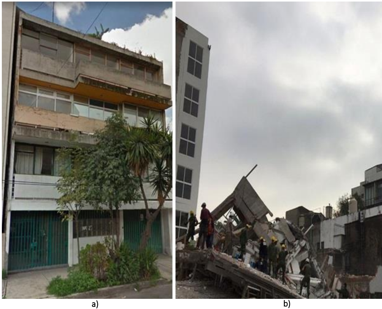
Figura A. 17 Edificio en Bretaña No. 90: a) antes del evento sísmico y b) después del evento sísmico de M7.1 ( http://bit.do/d3u65 )
