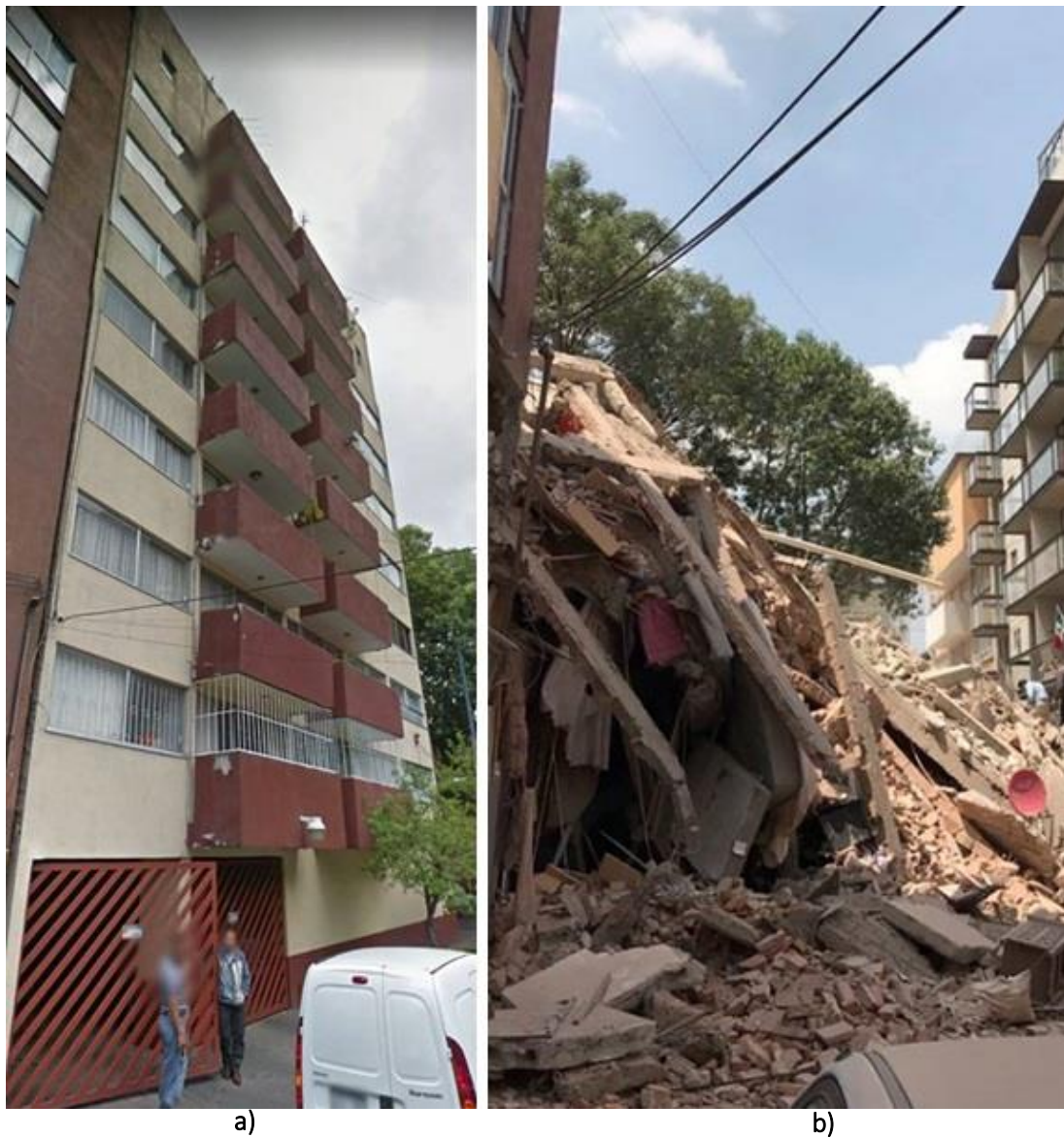
Figura A. 2 Edificio en Escocia No. 14: a) antes del evento sísmico y b) después del evento sísmico de M7.1 ( http://bit.do/d3u65 ).
