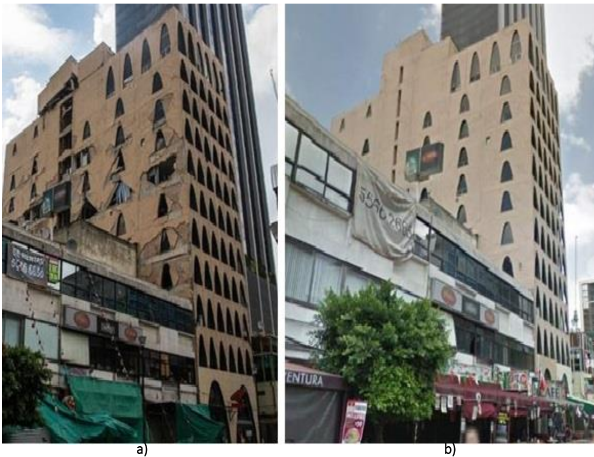
Figura A. 32 Edificio en Calle Génova No. 33: a) antes del evento sísmico y b) después del evento sísmico de M7.1( http://bit.ly/2rKx4Db )
