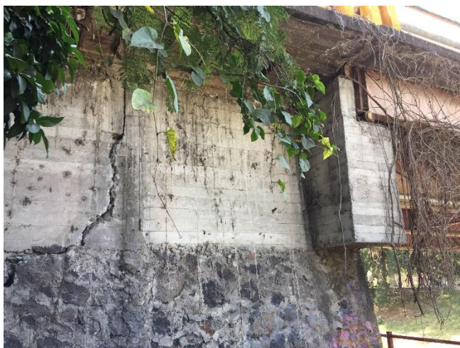
Figura 2.12 Fractura del muro de contención del terraplén de acceso , la fractura visiblemente es de 7 cm de espesor
