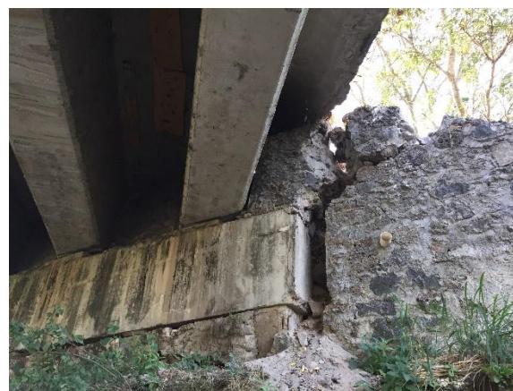
Figura 2.13 Fractura del muro de contención del terraplén de acceso , la fractura visiblemente es de 7 cm de espesor
