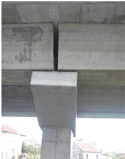
Figura 3.4 Apoyo simple de las vigas de un viaducto. Manuel Torres Búa. Licencia CC-BY-SA
