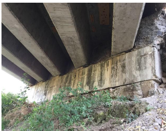
Figura 2.13 Fractura del muro de contención del terraplén de acceso , la fractura visiblemente es de 7 cm de espesor
