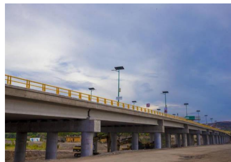
Figura 3.3 Puente vehicular Miguel Alemán(Obras WEB, 2014)
