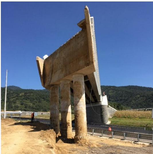
Figura 2.11 Falla del elemento estructural que conecta al puente con el terraplén de acceso, causado por la inestabilidad del talud
