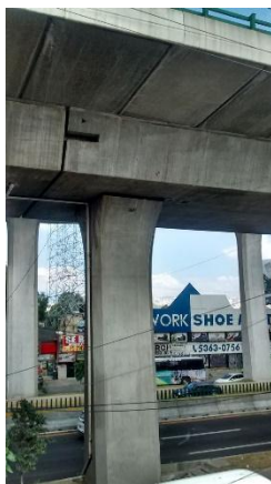
a) Columnas. Viaducto Bicentenario tramo Echegaray
