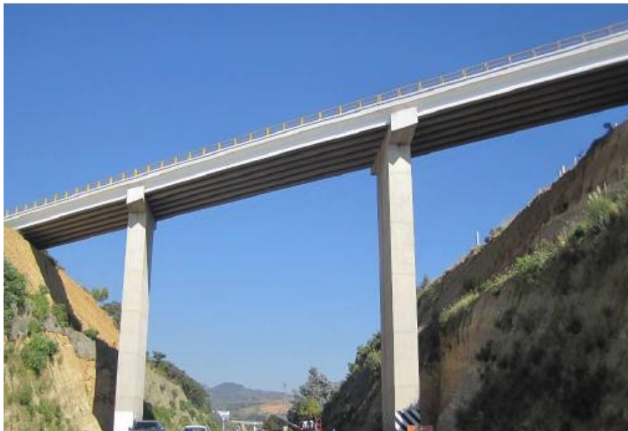
Figura 6.1.- Puente del kilómetro 25+900 de la autopista “La venta- Chamapa”
