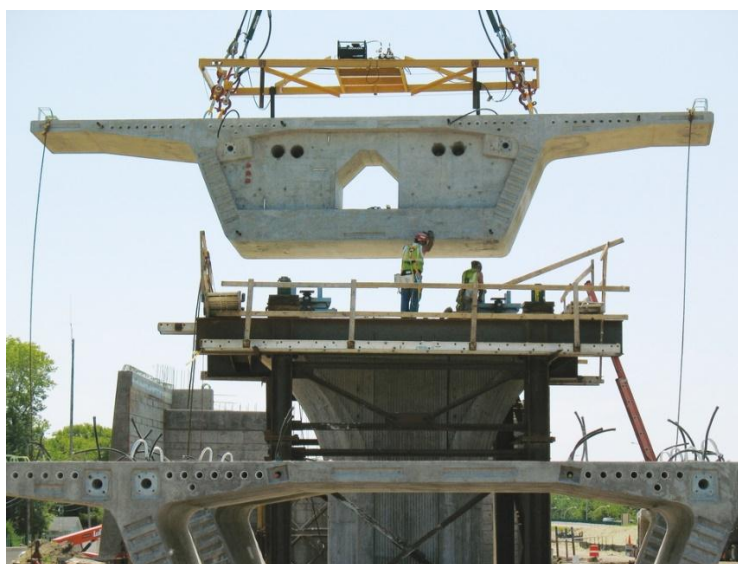
Figura 3.1 Colocación de trabe tipo cajón.
