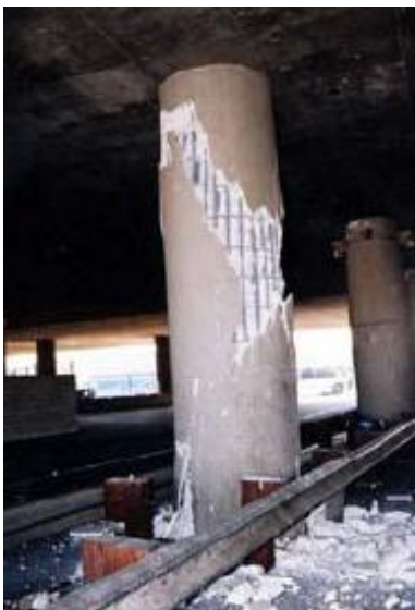
Figura 2.6 Falla de las columnas por cortante en sismo de Northridge 1994 (Barriga, 2011)
