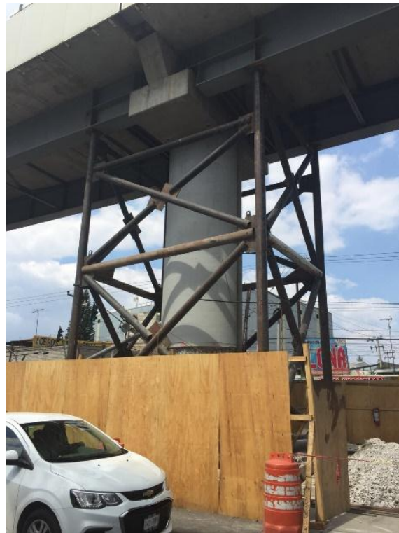
Figura 2.10 Puente del STCM
