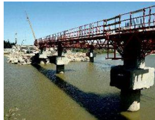
Figura 3.12 Cimentación con pilas de un puente en construcción (“IV Centenario: el puente roto | Noticiasnet”, s/f)
