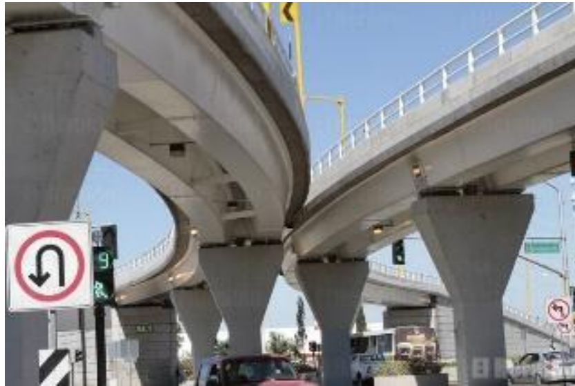
Figura 3.7 .- Puente vehicular planta curva (“Faltan puentes vehiculares | El Heraldo de Aguascalientes”, s/f)
