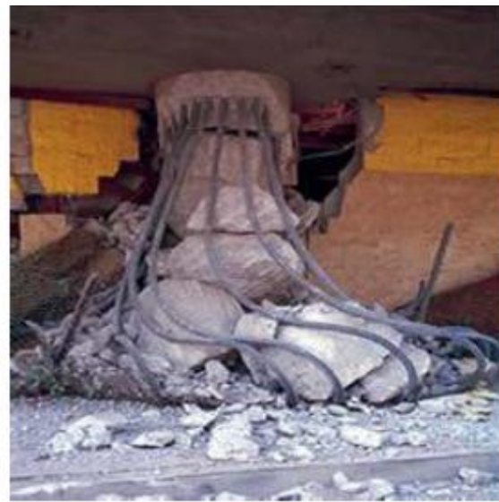
Figura 2.6 Falla de las columnas por cortante en sismo de Northridge 1994 (Barriga, 2011)
