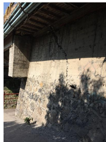
Figura 2.12 Fractura del muro de contención del terraplén de acceso , la fractura visiblemente es de 7 cm de espesor
