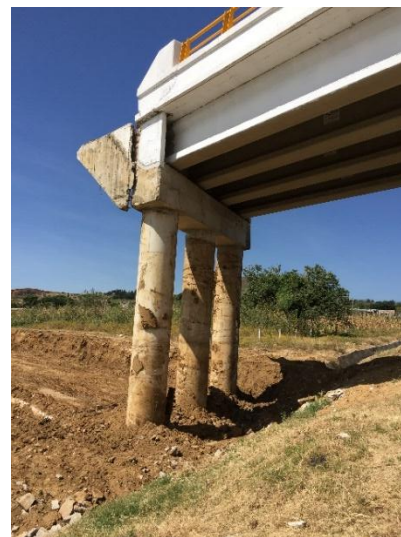
Figura 2.11 Falla del elemento estructural que conecta al puente con el terraplén de acceso, causado por la inestabilidad del talud
