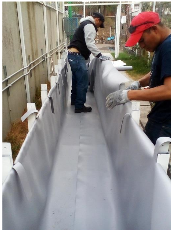
Figura 9 Colocación de la geomembrana de PVC
