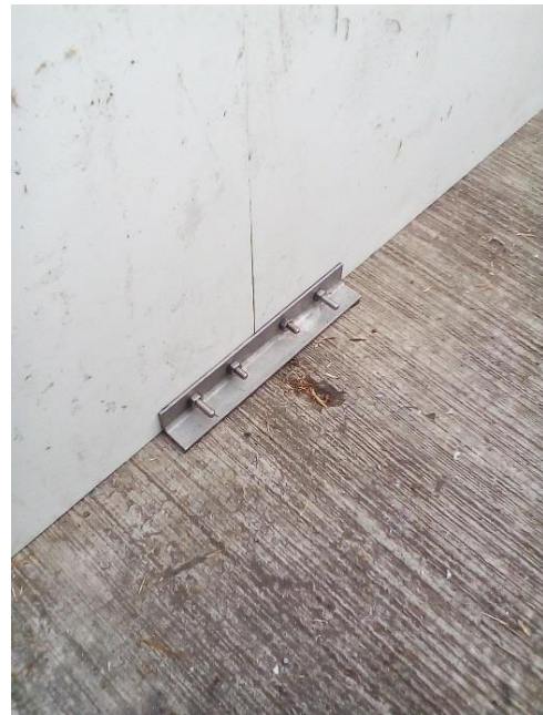
Figura 13 Unión de láminas con acero inoxidable
