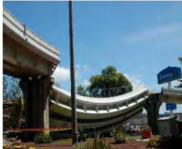
Fotografía 6. Vista frontal del tramo colapsado.
