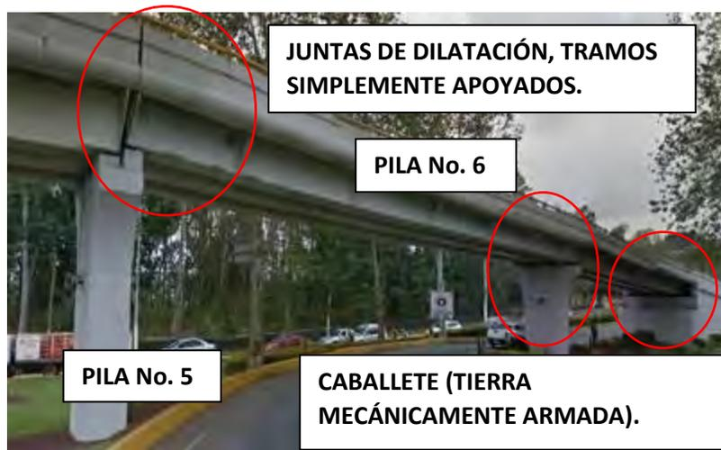
Fotografía 23. De la pila No.5 a la pila No. 6 y al caballete (tierra mecánicamente estabilizada), existen juntas, esto nos dice que son claros simplemente apoyados.
