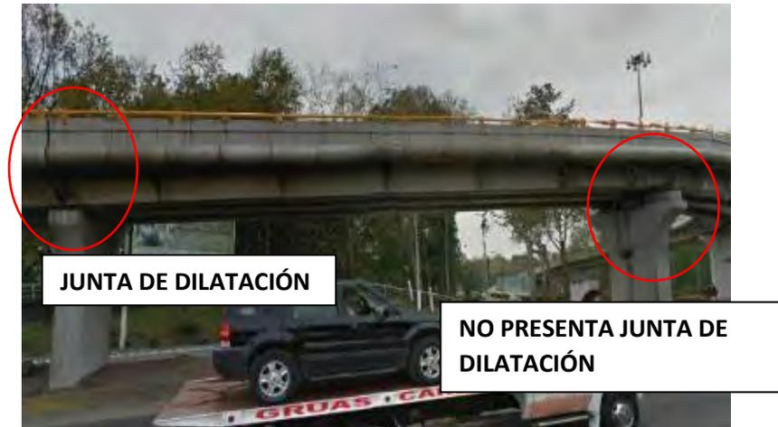
Fotografía 20. Inicio de tramo continuo, de la pila 2 a la pila 3.
