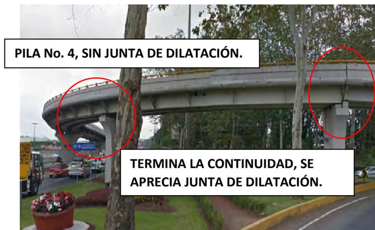
Fotografía 22. Termina la continuidad del puente en la pila 5, ya que se presenta una junta de dilatación.
