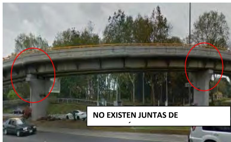
Fotografía 21. No se presentan juntas de dilatación en este trayecto del puente (tramo de 30 m en curva), perpetua la continuidad del puente, de la pila 3 a la pila 4.
