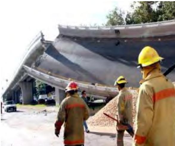
Fotografía 7. Superestructura del tramo colapsado.
