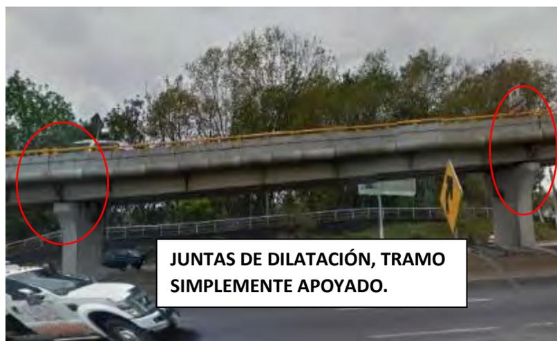
Fotografía 19. Tramo simplemente apoyado del puente, pila 1 a pila 2.
