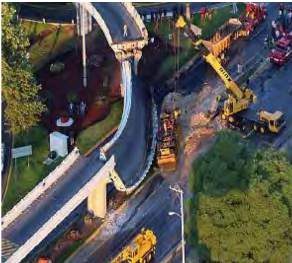
Fotografía 1. Vista aérea del PSV colapsado.
