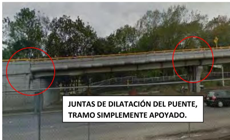
Fotografía 18. Tramo 1, caballete inicial (tierra mecánicamente estabilizada) a pila 1, simplemente apoyado.
