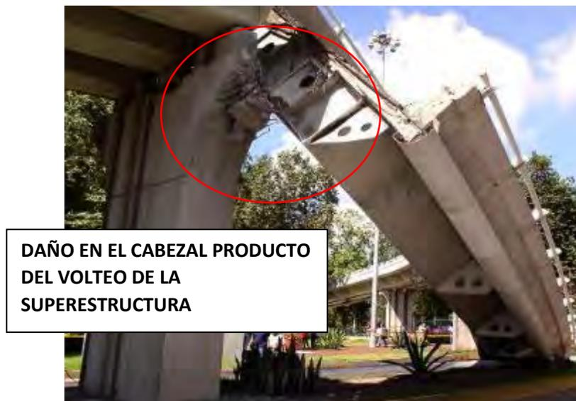
Fotografía 11. Daños en la subestructura.
