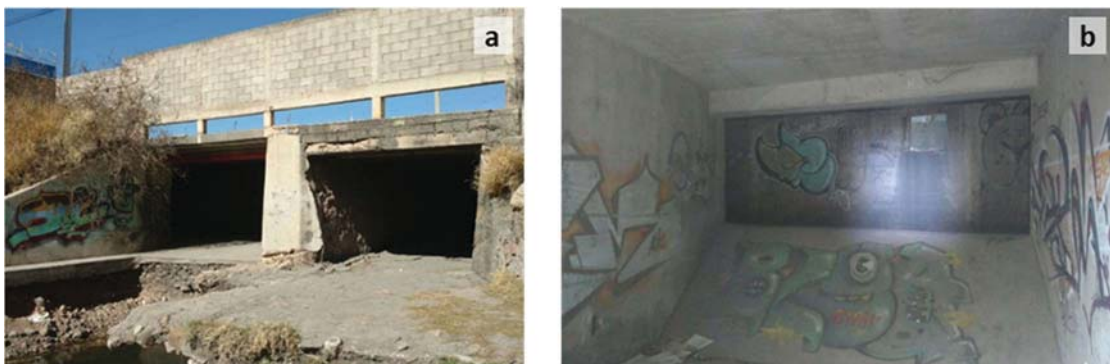
Figura 73.- Estructura de salida (a) y estructura de conexión (b). Fuente: propia.
