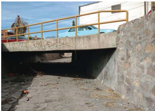
Figura 40.- Ejemplo de uso de suelo: mampostería. Fuente: propia.
