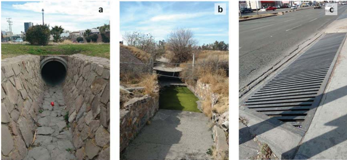
Figura 74.- Estructura de cruce (a), estructura de conducción (b) y estructura de captación (c). Fuente: propia.
