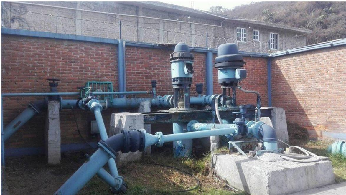
**Ilustración 18:** Bombas conectadas en paralelo con potencia de bombeo de 120HP - 150HP.
