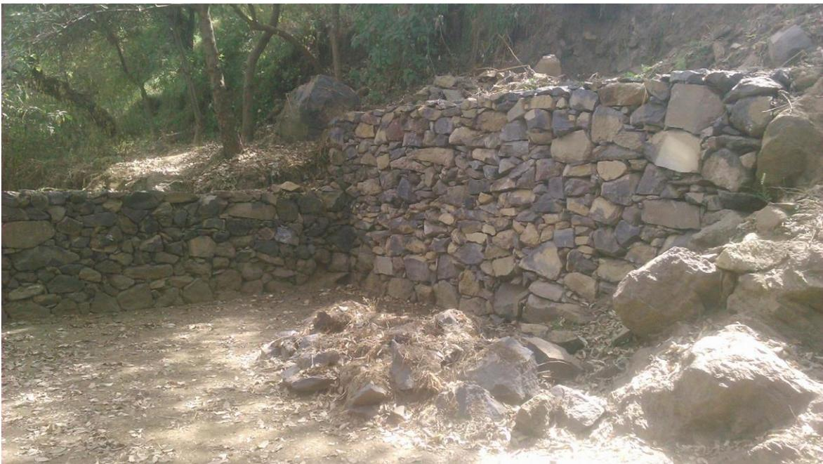
**Ilustración 27:** Tipo de roca que se empleará en la construcción del tanque de regulación y que abunda en la zona.
