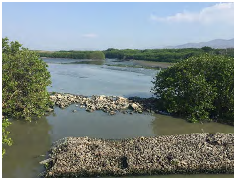
Figura 5. 2. Estado actual del dique. Fuente: Fotografía en sitio, febrero 2018.
