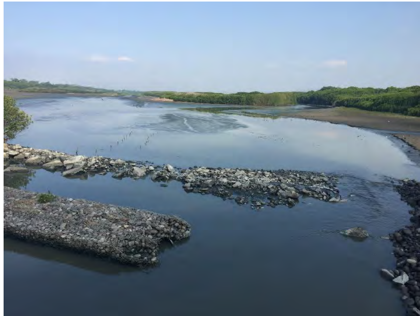
Figura 5. 1. Estado actual del dique. Fuente: Fotografía en sitio, febrero 2018.
