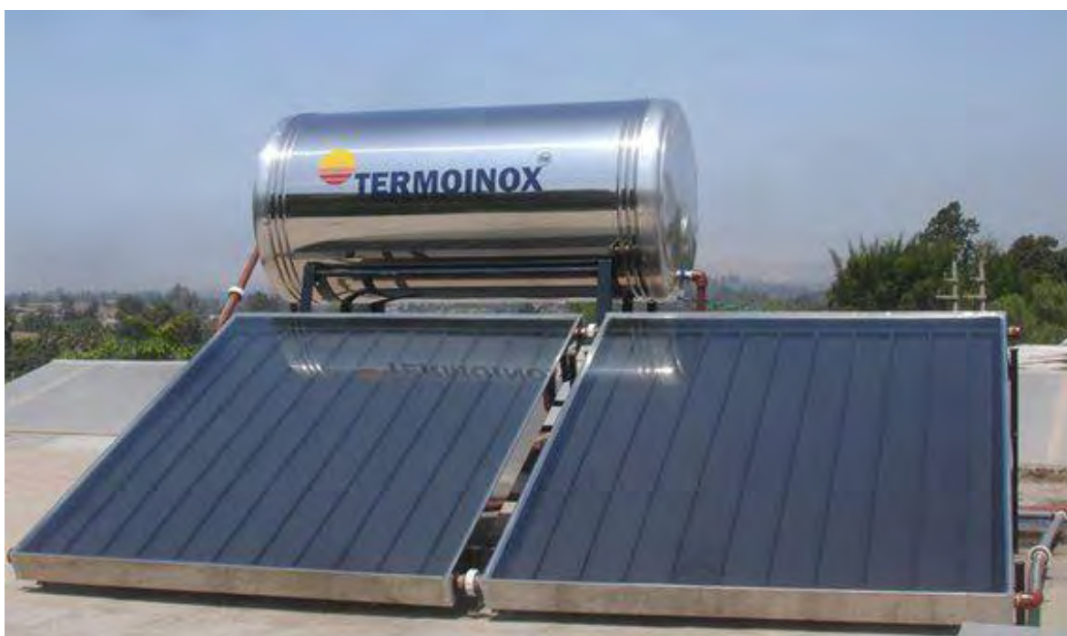
Ilustración 37 calentador solar de placa plana (calentamiento indirecto) y convección libre.
