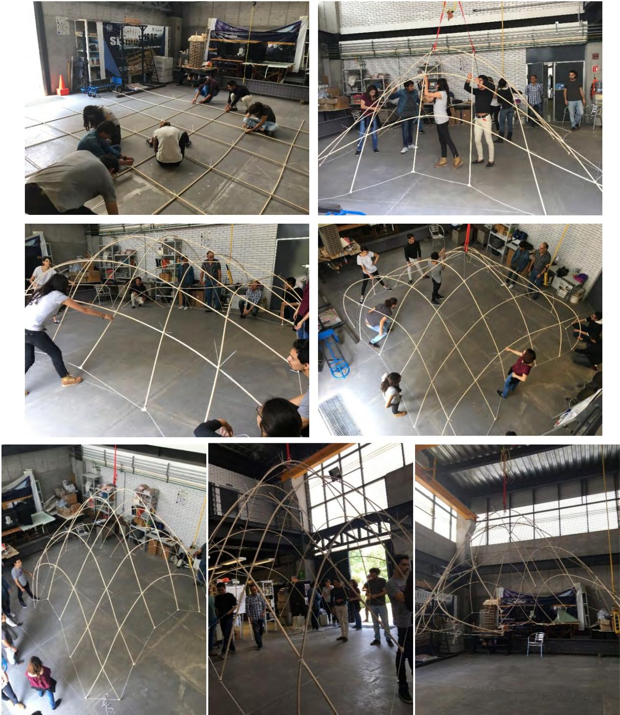
Figura 27. Dinámicas de grupo simulando cascarones reticulados y estructuras espaciales reticuladas
