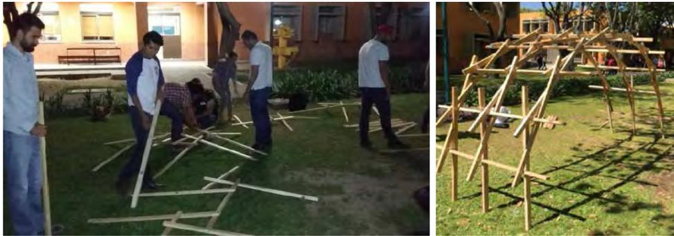
Figura 9. Alumnos elaborando estructuras de marcos recíprocos. Fuente: N. Gutiérrez, et al. [22]
