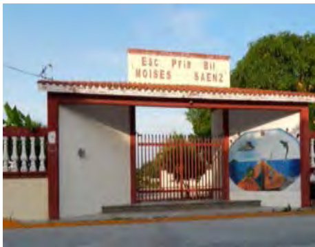
Figura 3. Entrada principal de la Escuela
