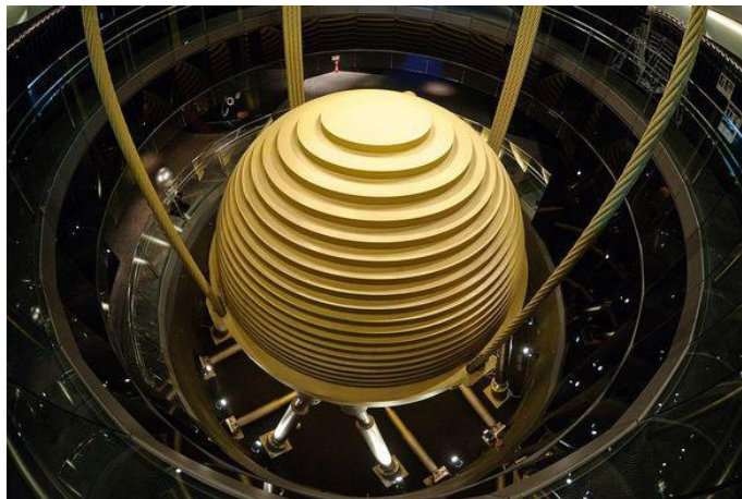
Fig. II. 11 Oscilador de masa sintonizada TMD (Imagen de “ technoclass3b.wordpress.com ”)
