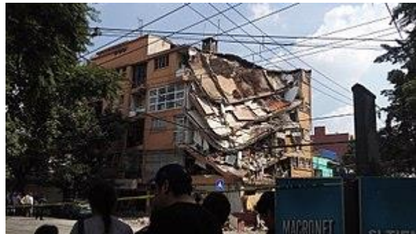
Fig. 1.9 Edificio afectado por el sismo en la delegación Benito Juárez (Imagen de "Diario de Huila")
