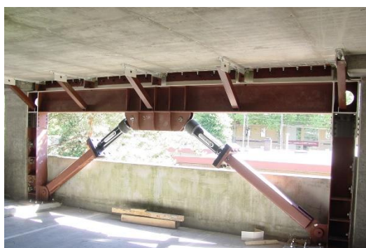
Fig. II. 8 Amortiguadores viscosos 1 (Imagen de "architecture.org.nz")
