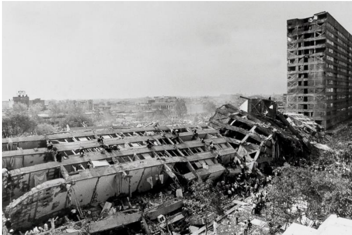
Fig. I.5 Edificio Nuevo León en Tlatelolco colapsado debido al Sismo del 85 (Imagen de "La Jornada Baja California")
