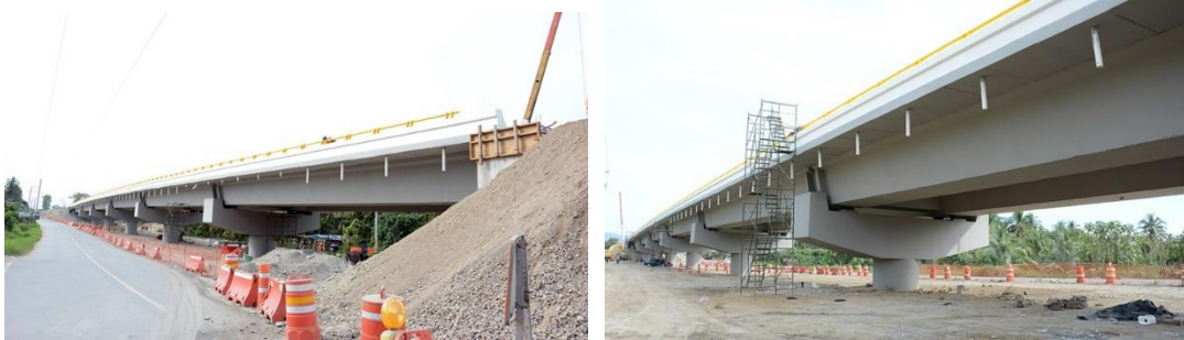
Fig. IV. 12 Puente Cuajilote implementado con aisladores de base (Imágenes de www.obrasweb.mx )
