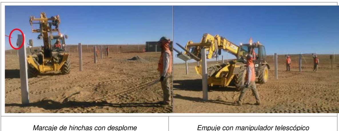
Figura 3.7 Proceso de corrección de verticalidad en hincas (fuente: Manual de Instalación de Seguidores Solares, Soltec Rev. 00)
