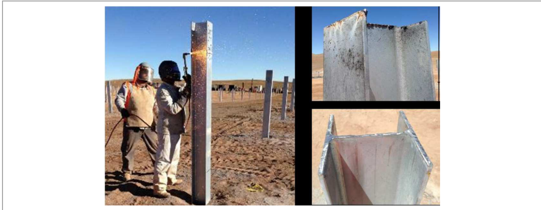
Figura 3.8 Proceso eliminación de excedencias en hincas
