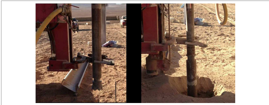
Figura 3.6 Proceso barrenación para facilitar el hincado en estratos duros
