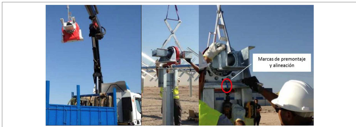
Figura 3.13 Reparto, montaje y alineación de reductoras de transmisión (fuente: Parque fotovoltaico Don José, San Luis de la Paz, Gto.)
