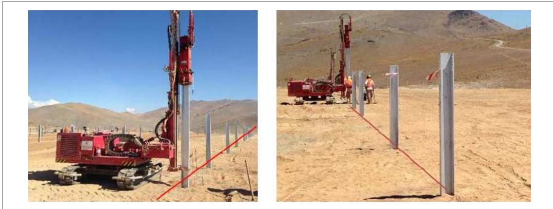
Figura 3.5 Proceso del hincado
