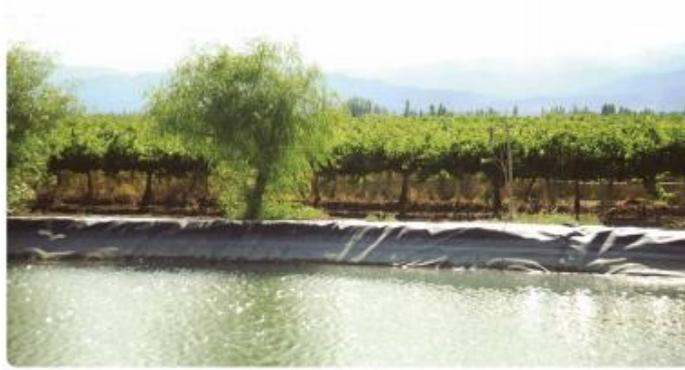
*Figura 3. Reservorio con geomembrana*
