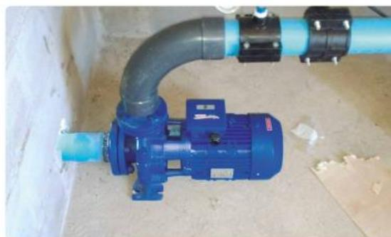
*Figura 5. Bomba centrífuga de riego*
