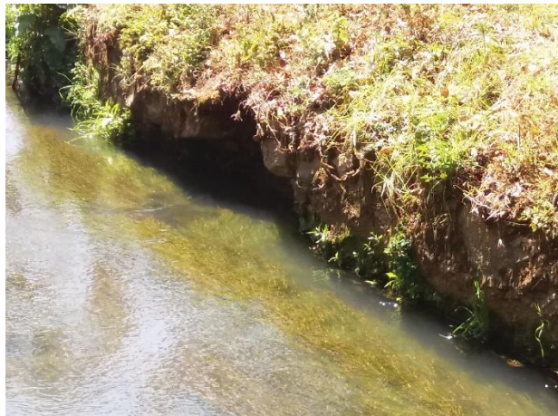
Imagen 3.7 Socavación en los taludes
