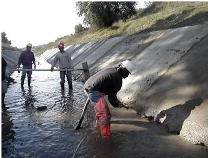
Imagen 2.3 revestimiento con mortero
