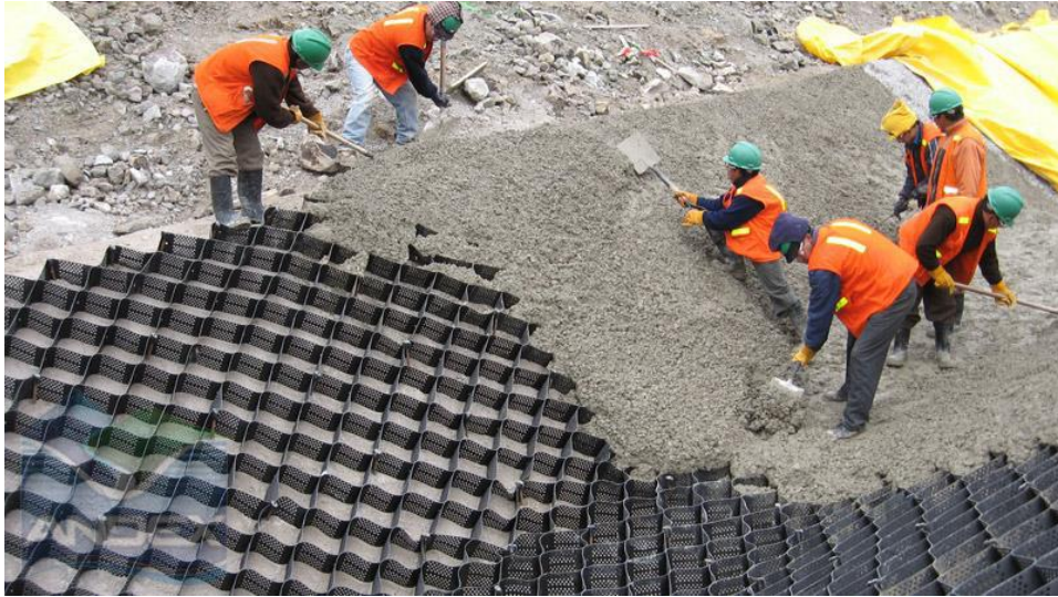
Imagen 2.4 recubrimiento con concreto asfáltico
