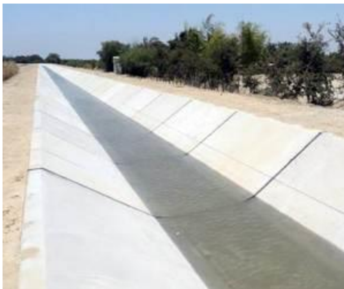
Imagen 2.2 Canal revestido de concreto.
