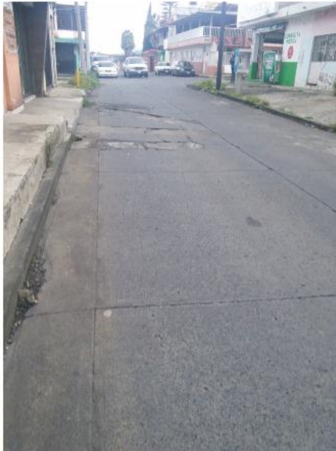
Imagen 3.10.- Drenaje domiciliario en malas condiciones, calle 5 de febrero.
