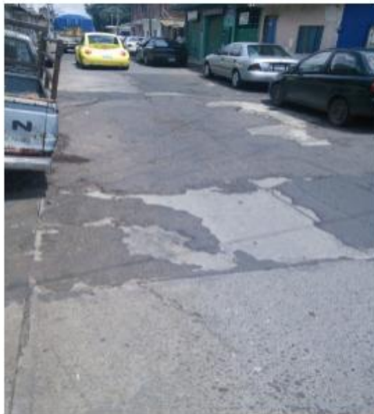
Imagen 3.4.- Pavimento fracturado en la Calle Veracruz.
