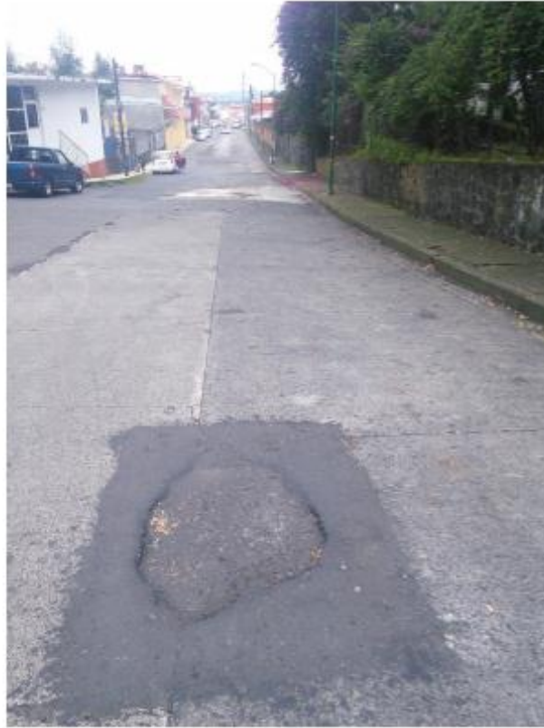
Imagen 3.8.- Calle Isaac Arriaga pavimento dañado.
