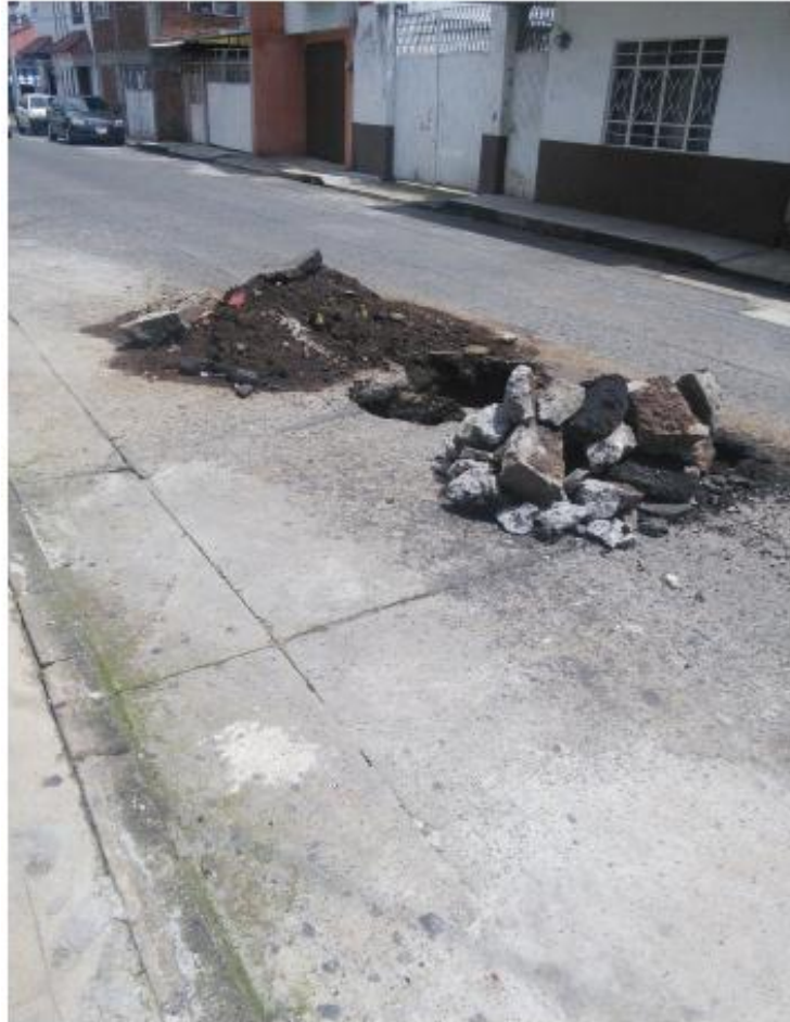
Imagen 3.6.- Pavimento dañado en la calle Monterrey.
