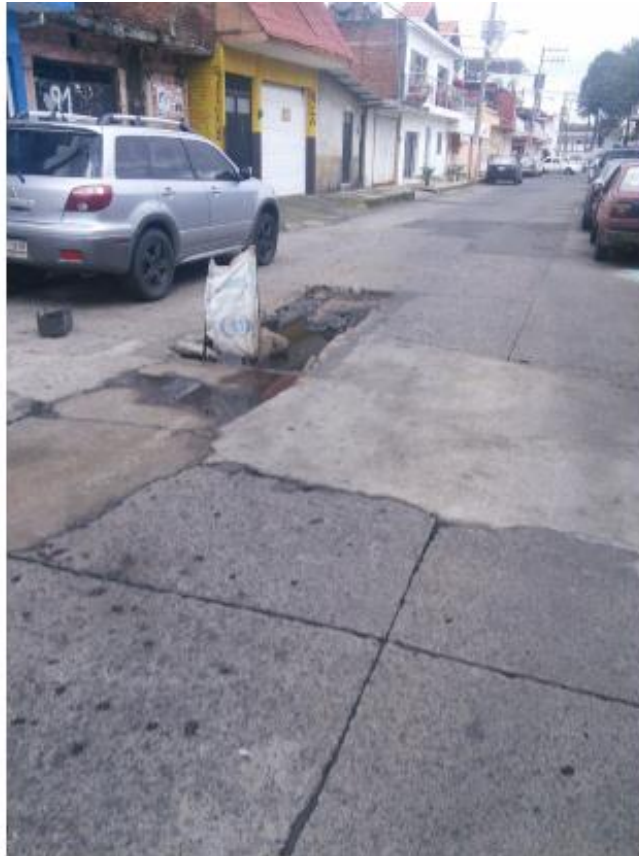
Imagen 3.5.- Pavimento fracturado en la Calle Veracruz.
