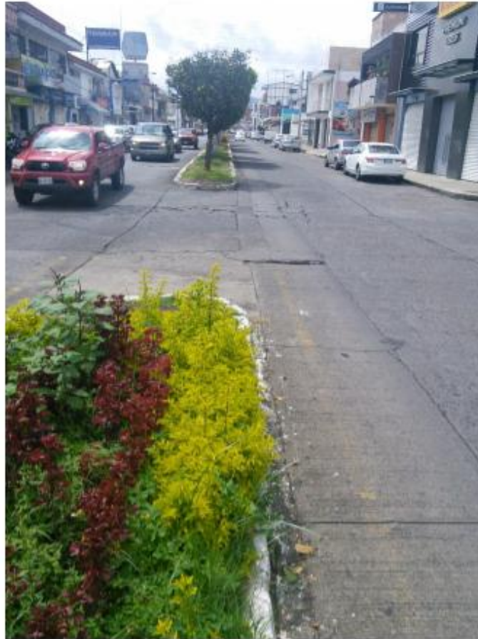
Imagen 3.11.- Avenida las Américas deteriorada por el sistema de drenaje.
