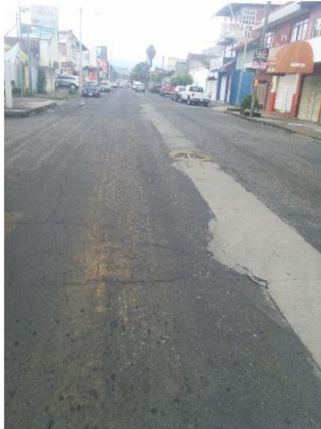
Imagen 3.12.- Avenida Benito Juárez, drenaje en malas condiciones.
