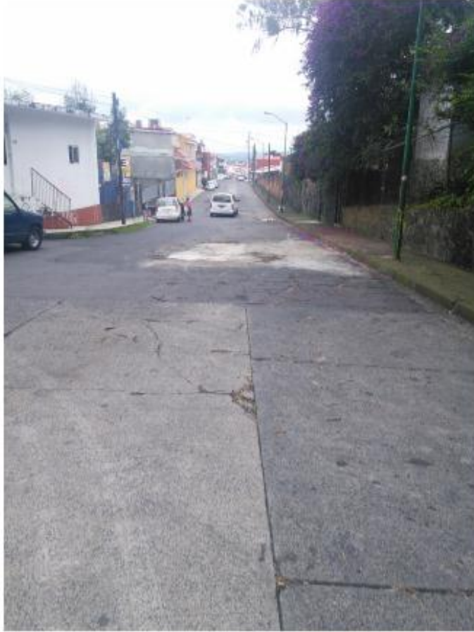
Imagen 3.7.- Calle Isaac Arriaga pavimento dañado.
