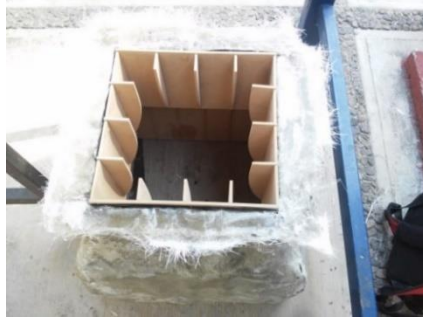
Figura 6.14 Resanando Tapa del Colector
