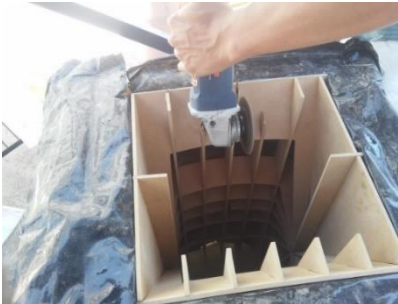
Figura 6.45 Desmontaje de la Estereotomía
