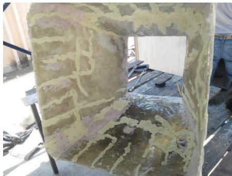
Figura 6.20 Espuma de Poliuretano en el Colector
