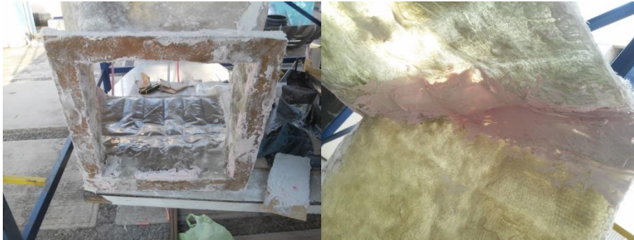
Figura 6.19 Resanada del Colector
