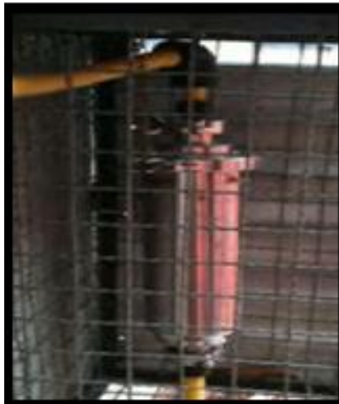
Figura 3.8 Desulfurador de biogás (Grimaldo, 2013)
