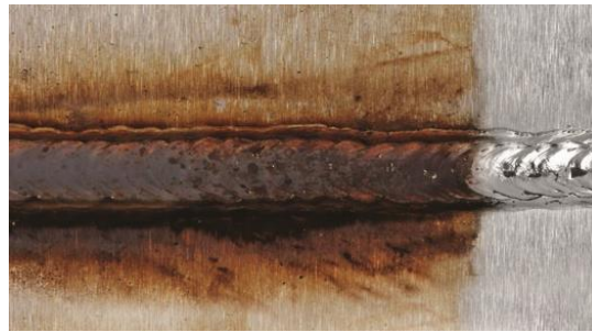
Figura 2.4 Corrosión selectiva de la costura
