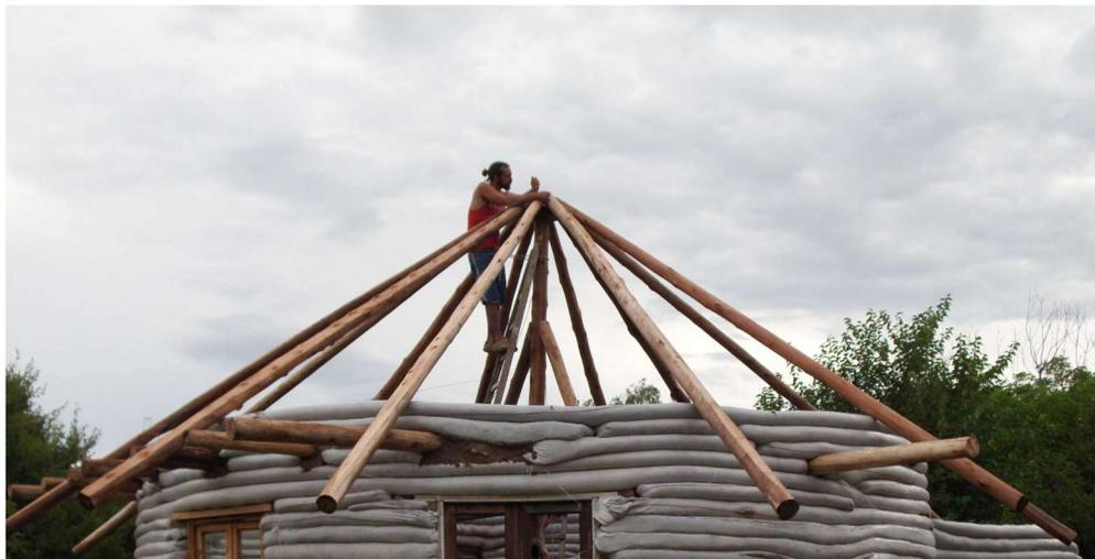
Fig.26. Estructura de madera para cubierta cónica de la vivienda
