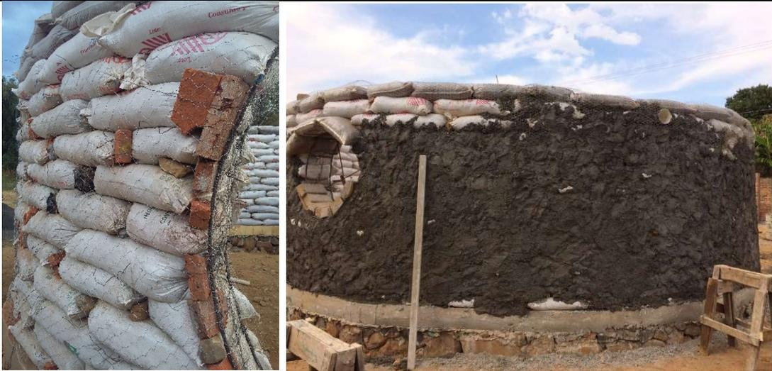
Fig.25. Colocación de tela de gallinero y aplanado
