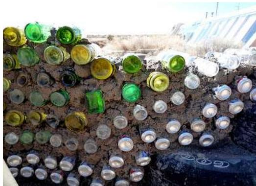
Figura 8. Muro de botellas de vidrio reciclado.
