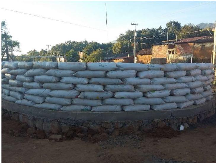
Fig. 22. Levantamiento de muros con superadobe traslapados
