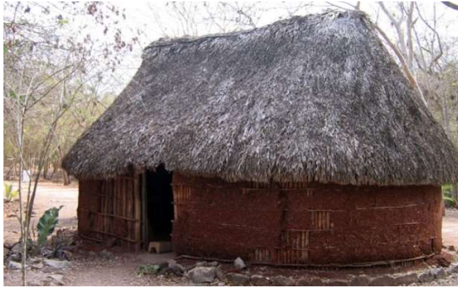
Figura 10. Arquitectura Maya de muros redondos que permiten a los fuertes vientos de huracanes rodear los muros. Fuente: Betanzos, M. (2012). Vivienda Maya, una solución constructiva vigente, en www.metrocubicos.com , consultado el 27 de septiembre de 2017
