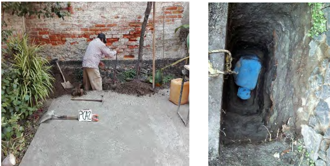
Figura 4 Realización del pozo a cielo abierto
