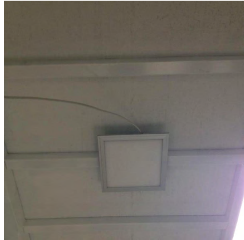
Figura 49 Montaje de luminaria en plafón. Elaboración propia.
