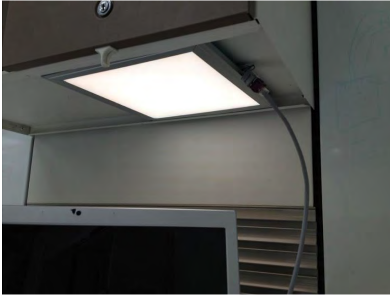
Figura 50 Montaje de luminaria en estación de trabajo. Elaboración propia.
