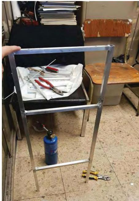
*Fig. 27 Soldadura de estructura. Desarrollo propio.*
