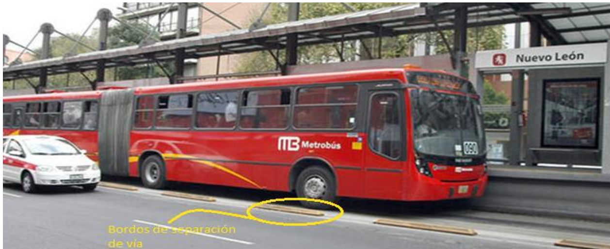
Figura 42 Separación de vía tipo B en el Metrobús de la Ciudad de México (Fuente: Notimex. 29 de julio del 2016. Elaboración propia)
