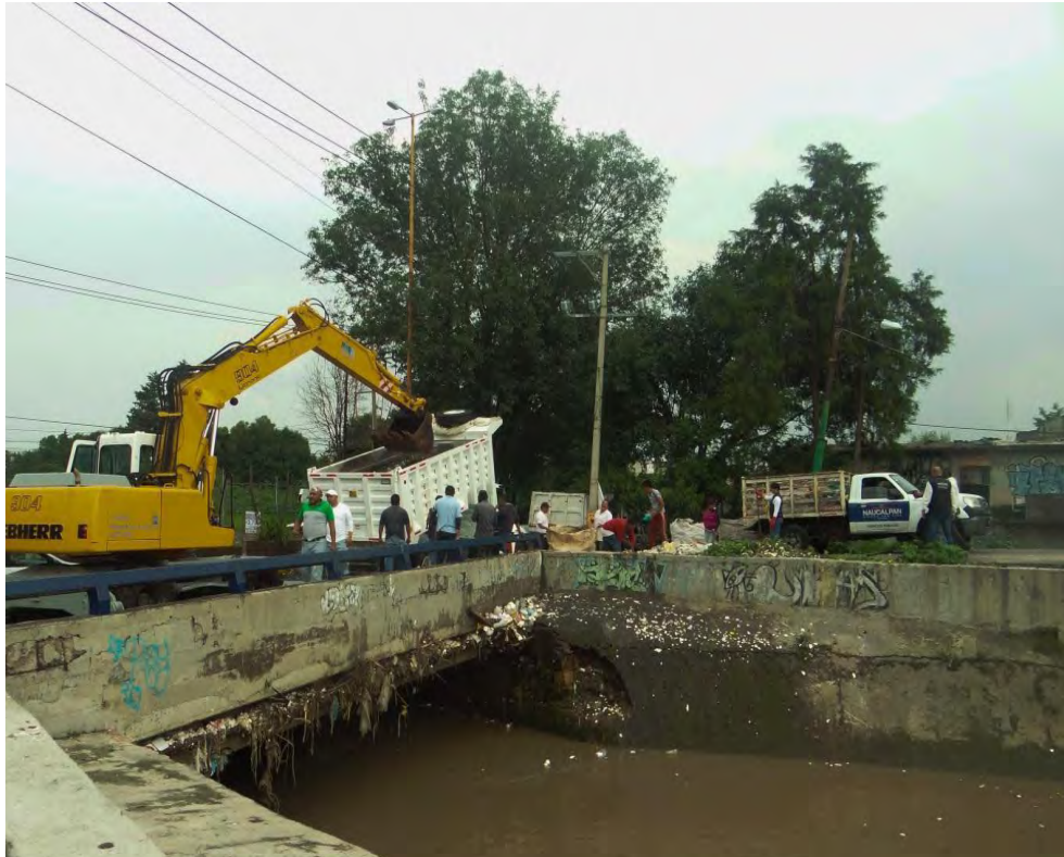
Fotografía 12: Desazolve llevado a cabo por el ayuntamiento de Naucalpan (Agosto 2017). Claudia T
