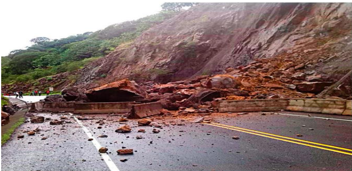
Figura 1.5 Fallo del talud, en la Ciudad de Caldera, Chile. Junio 2015
