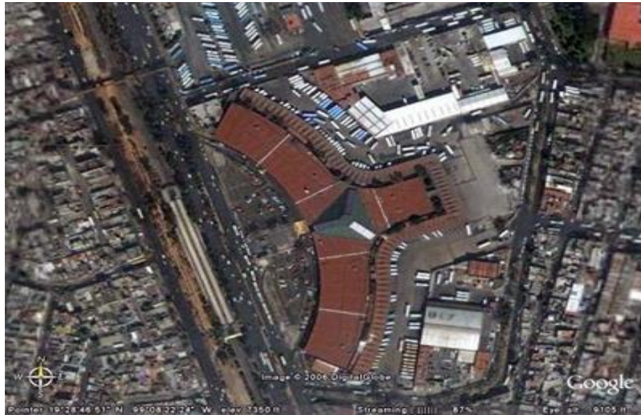
Ilustración Terminal Central Norte. CDMX
