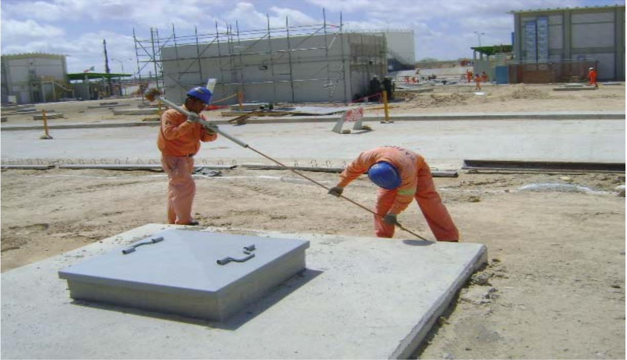
**Foto 4.9 Instalación de varilla copperweld**
