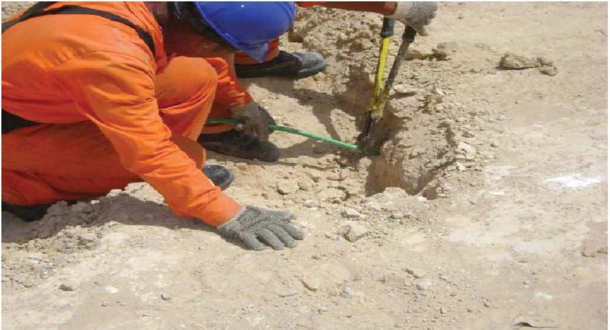
**Foto 4.4 Instalación de cable aislado de tierra**
