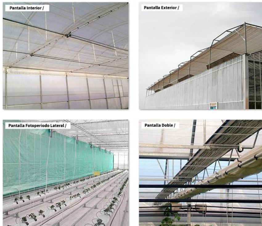
Figura 2.12 Tipos de pantallas térmicas
