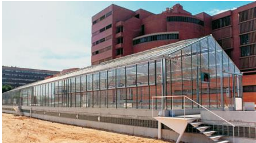
Figura 1.7 Invernadero tipo capilla
