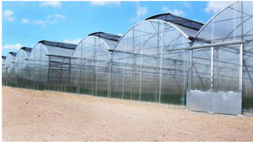
Figura 1.9 Invernaderos con cubierta curva
