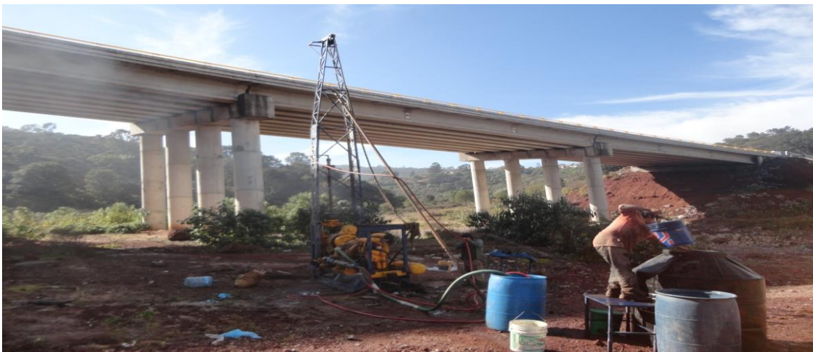
a) Vista general del equipo de perforación para los sondeos exploratorios.
