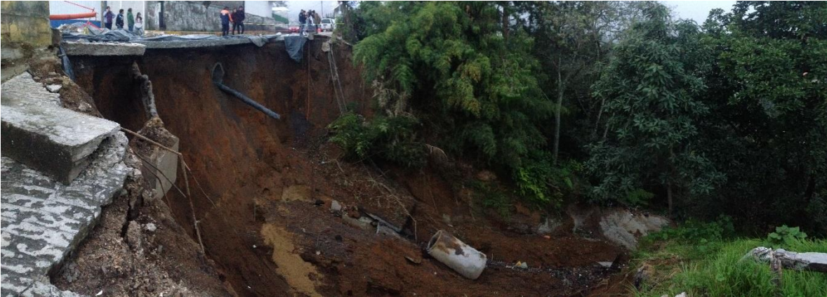
Figura 4.6 Deslizamiento en la colonia El Fortín (e).
