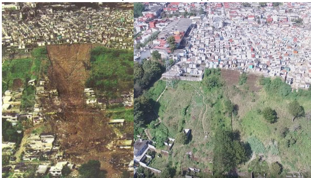
Figura 4.2 Vestigios del deslizamiento de 1999 en la ladera este del panteón municipal. Comparación 1999/2017 (a).
