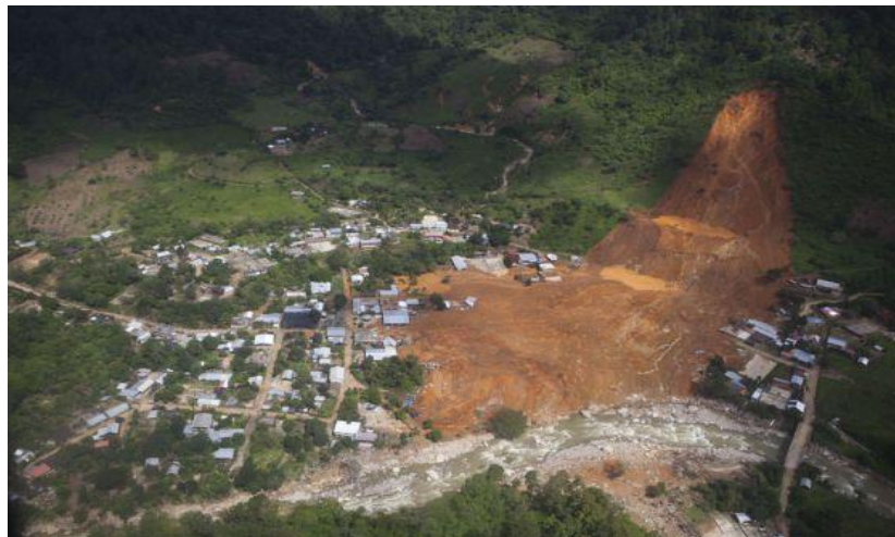
Figura 1.2 Deslizamiento en la localidad La Pintada, Atoyac de Álvarez, Guerrero
