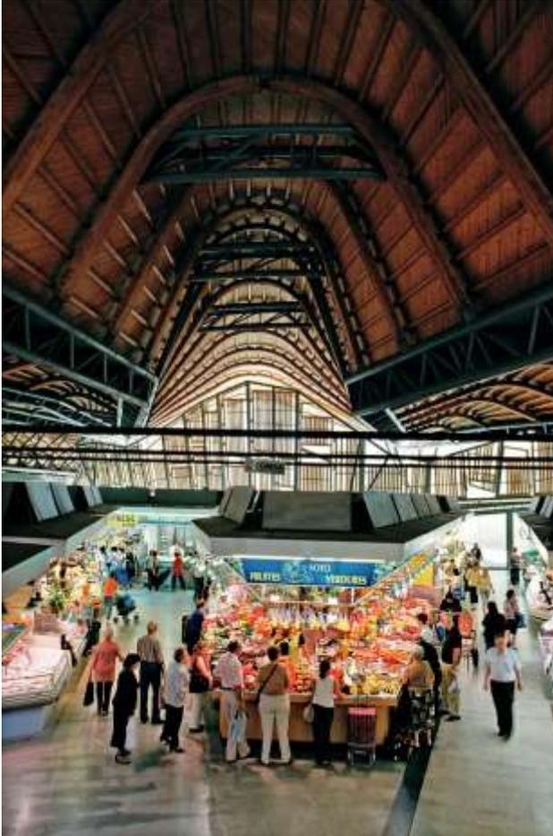
[17] *Mercado de Santa Caterina*, Miralles, 2001. Cubierta ligera elaborada de madera y cerámica con una estructura de vigas de acero que la sostienen.
