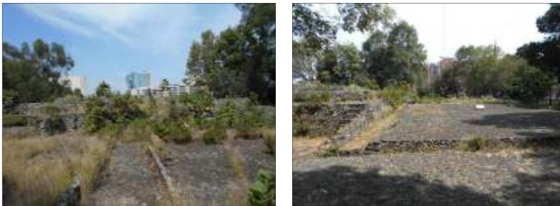
Figura 18. La Estructura II, ubicada dentro del complejo de Cuicuilco B, evidencia la falta de mantenimiento mínimo necesario para garantizar su preservación a largo plazo (Fotos del autor).
