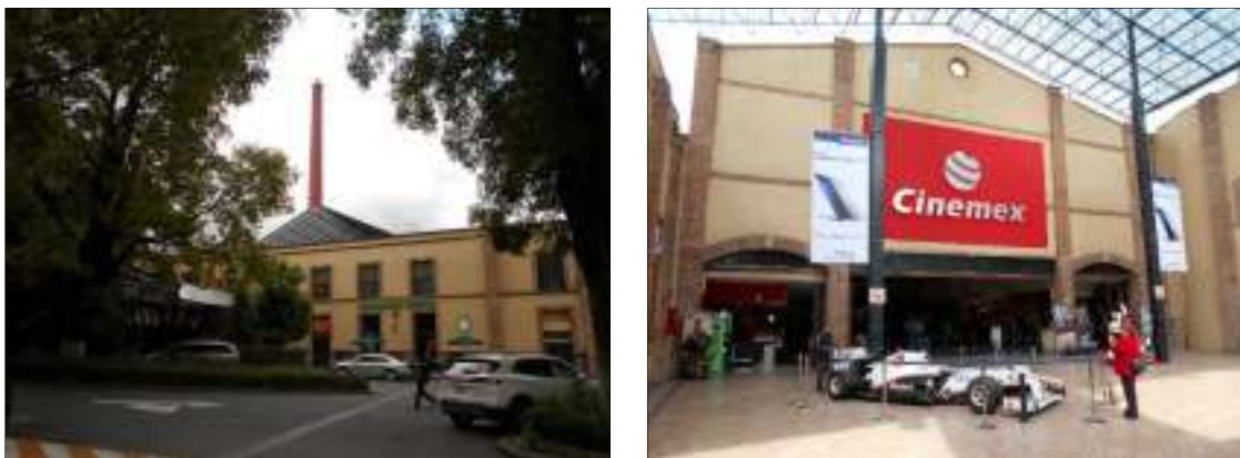
Figura 20. Estado actual de la antigua fábrica de Peña Pobre tras su reconversión como plaza comercial (Fotos del autor).
