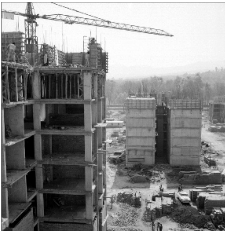
Figura 15. Construcción de la Villa Olímpica Liberador Miguel Hidalgo en 1968; al fondo se divisa el bosque del Pedregal o bosque de Tlalpan (Foto: INAH-SINAFO, 2010:296155).
