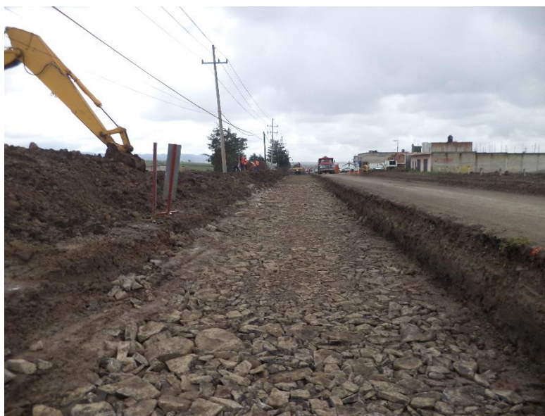
Figura 5.1 Acondicionamiento de humedad en carretera villa victoria – San José del Rincón
