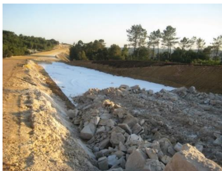
Utilización de Geotextiles en suelos blandos
