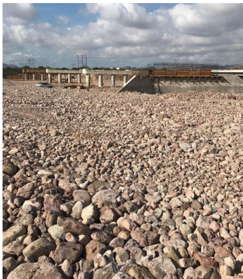
Figura 5.6 Compactación de Pedraplén con rodillo
