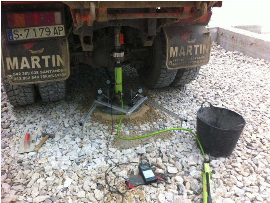
Figura 5.8 Ensayo placa de carga.
