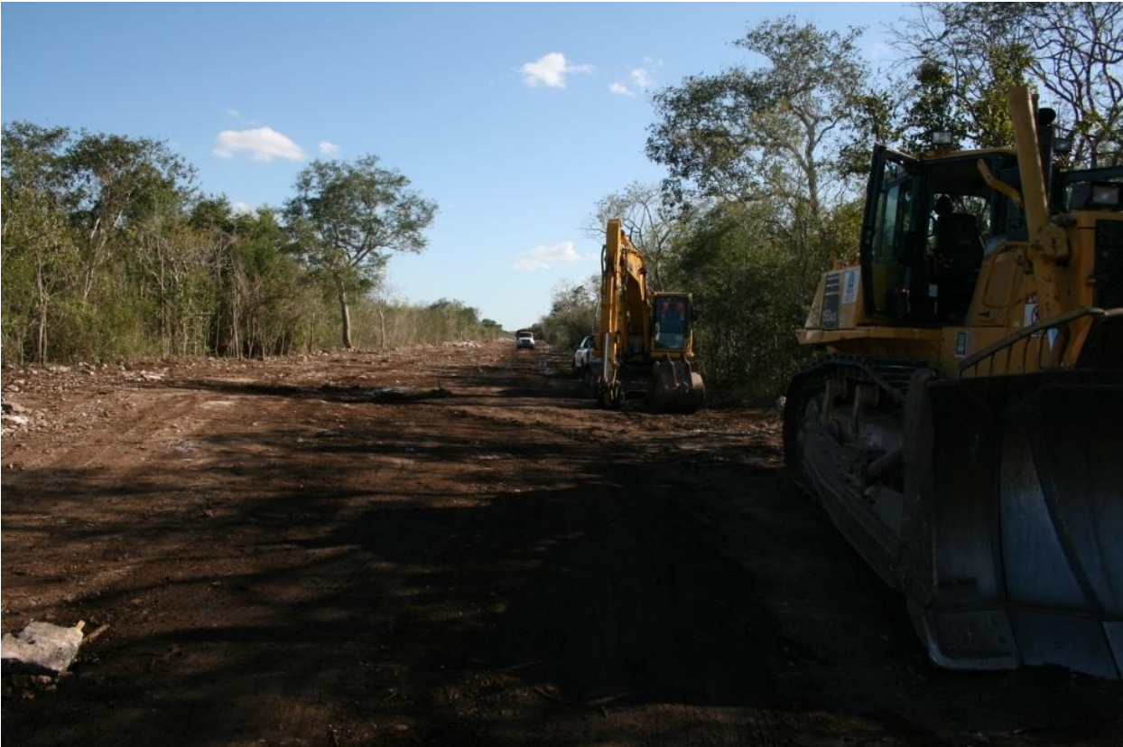
Figura 2.2. Despalme sobre la carretera Tuxtla – Gutiérrez Cd. Cuauhtémoc
