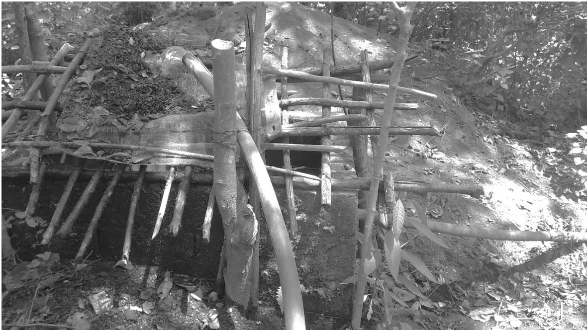
Figura 25. Malla que filtra el agua de hojas y tierra.
