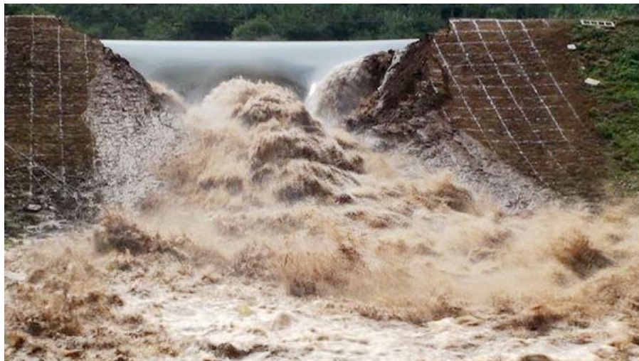
Figura 1.5 Falla de presa por acumulación de agua debido a insuficiente capacidad de descarga
