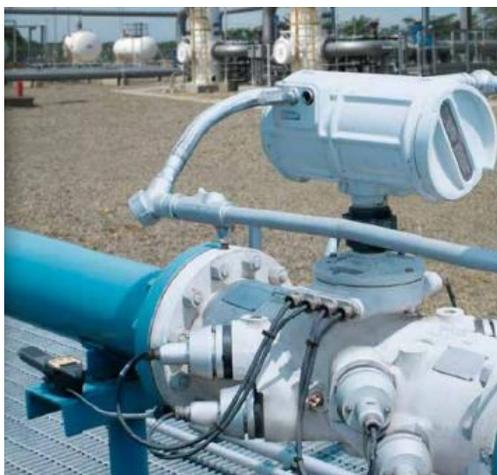
*Fig. 10 Ejemplo de Medidor Ultrasónico, por CENAM, 2016*
