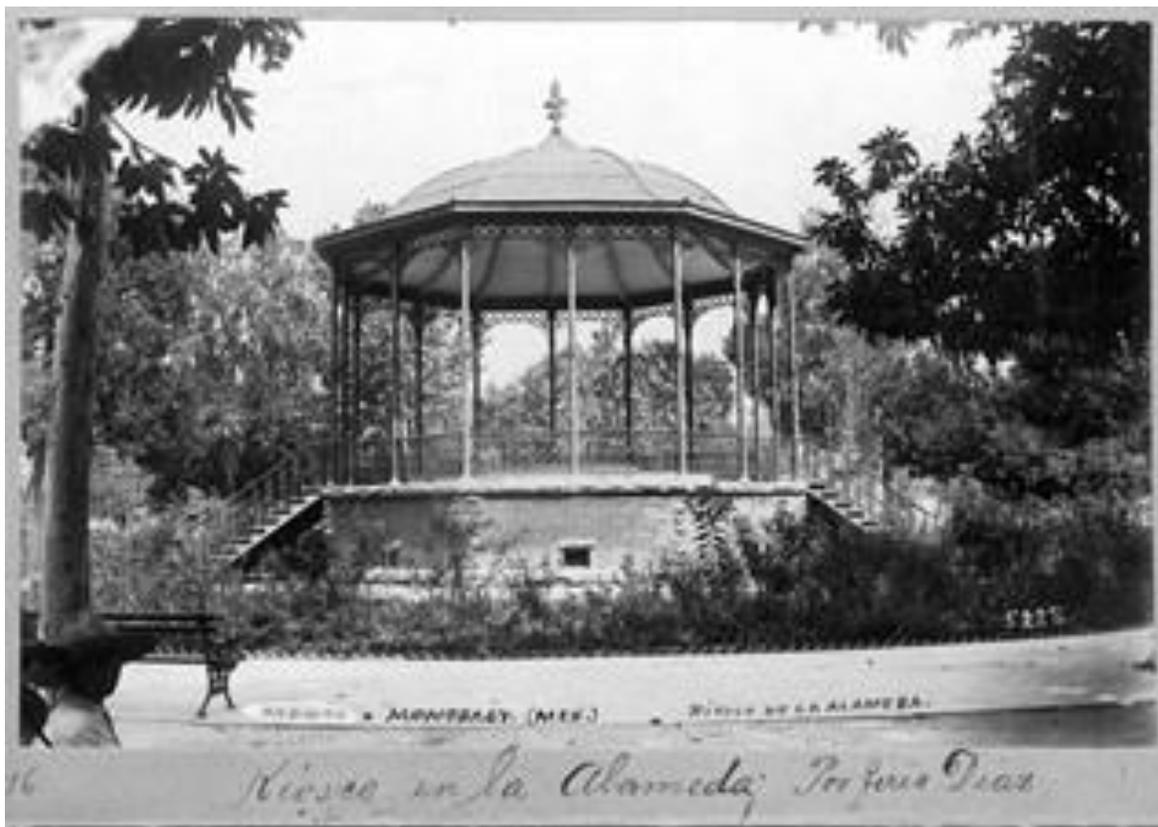
Imagen 3. Kiosco en la alameda de Monterrey. Se aprecia el diseño sobre el basamento con la doble escalinata. Las columnas metálicas y las ménsulas que bajan la carga de la cubierta, tocándose en un punto central con lo que parece que en cada tramo hubiera un arco, son un símbolo de la modernidad tecnológica del momento.
