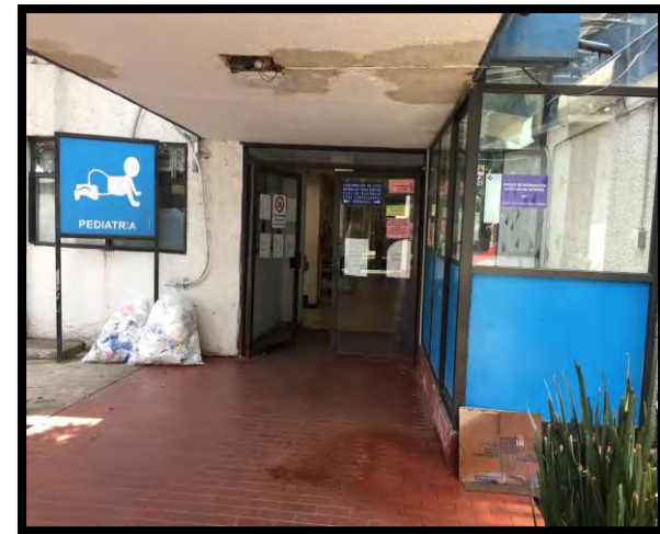
Imagen 19. Acceso principal al área pediátrica del hospital general.
