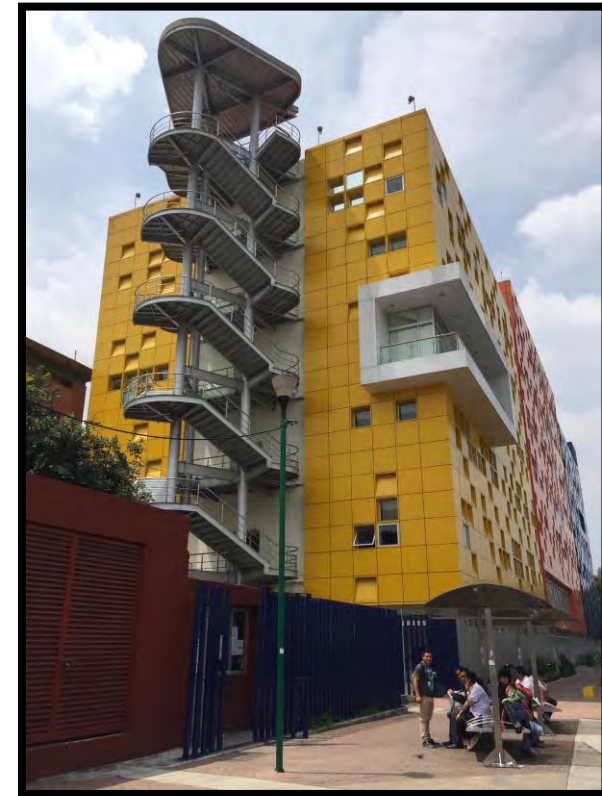
Imagen 6. Fachada principal lateral izquierda del hospital en la actualidad
