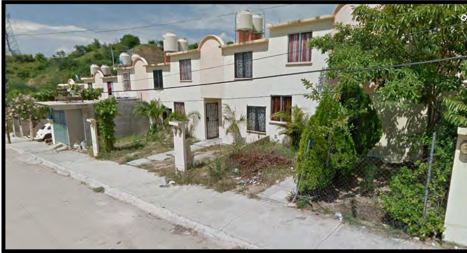
Imagen 38. Fachadas de la unidad habitacional San Agustín
