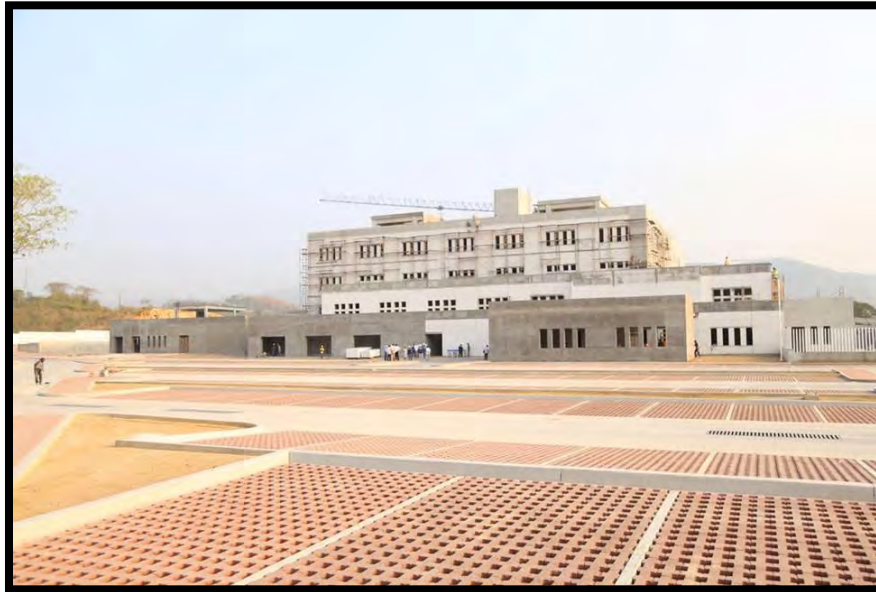
Imagen 36: Nuevo Hospital General, ubicado al otro lado de la calle del predio elegido.
