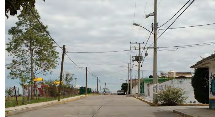
Fotografía 1.4 Tomada en la calle Unidad Iztapalapa a lado del predio // infraestructura eléctrica.
