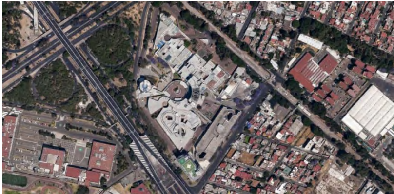
Imagen 1.15 Vista aérea del INR Fuente: Google Earth, 19°17'21.80 N, 99°08'56.92 O
