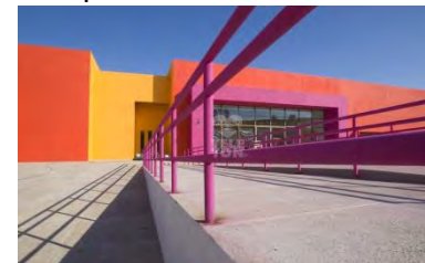
Fotografía 1.12 Entrada al CRIT Tamaulipas. Fuente: Fundación teletón México A.C. www.Flick.com/photos/teletonmexico
