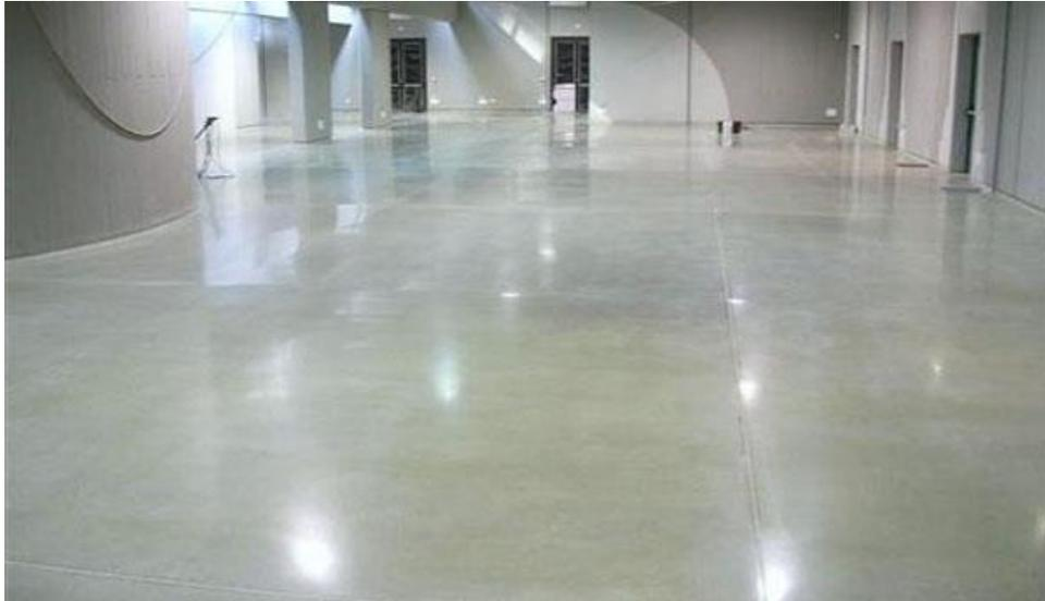
**FIGURA 36** Piso de concreto pulido [fotografía].
