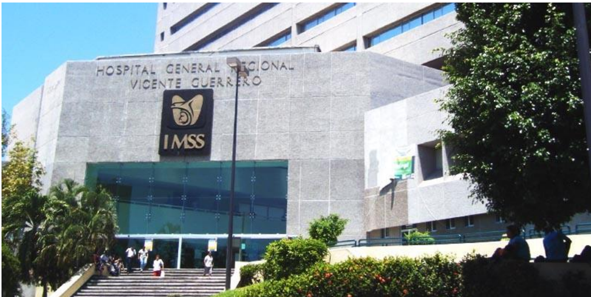
Ilustración 1.1 Hospital General Regional.
