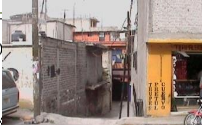
Toma 4 Vivienda por debajo del drenaje Municipal en calle de Las Flores
