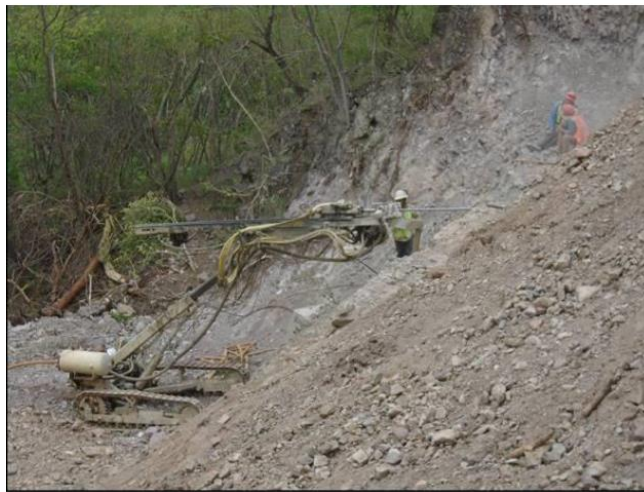
Fotografía 10. Perforación para la colocación de drenes.
