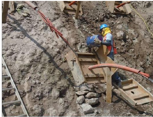
Fotografía 12. Colado de los dados de reacción, como sistema de protección del anclaje ante el intemperismo.
