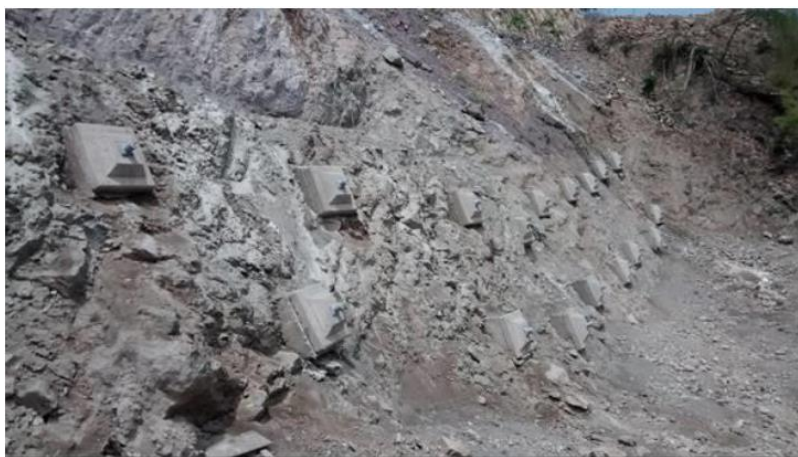
Fotografía 13. Vista final del muro con anclas de tensión.
