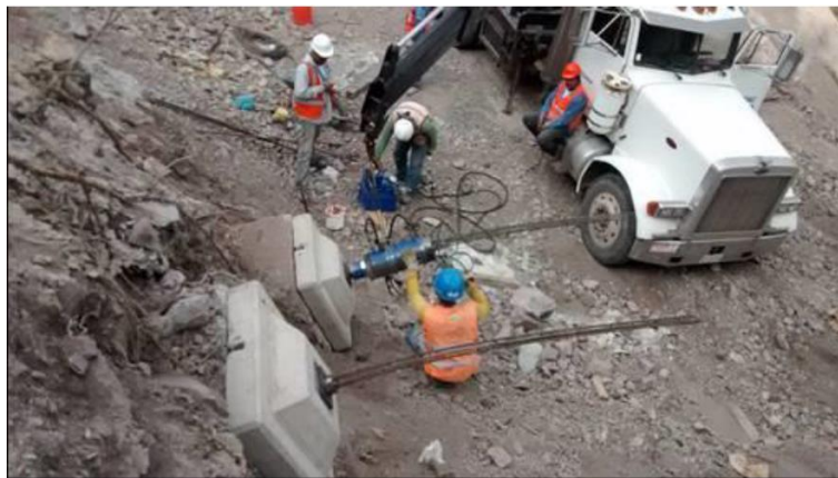
Fotografía 9. Tensado de las anclas mediante un gato hidráulico
