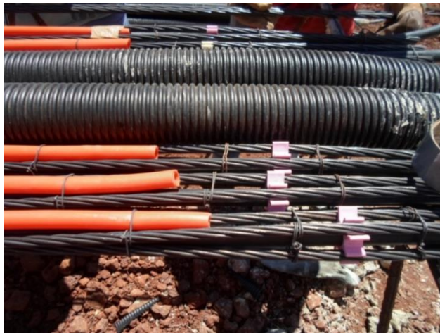
Fotografía 4. Habilitación del acero y colocación de mangueras de inyección.
