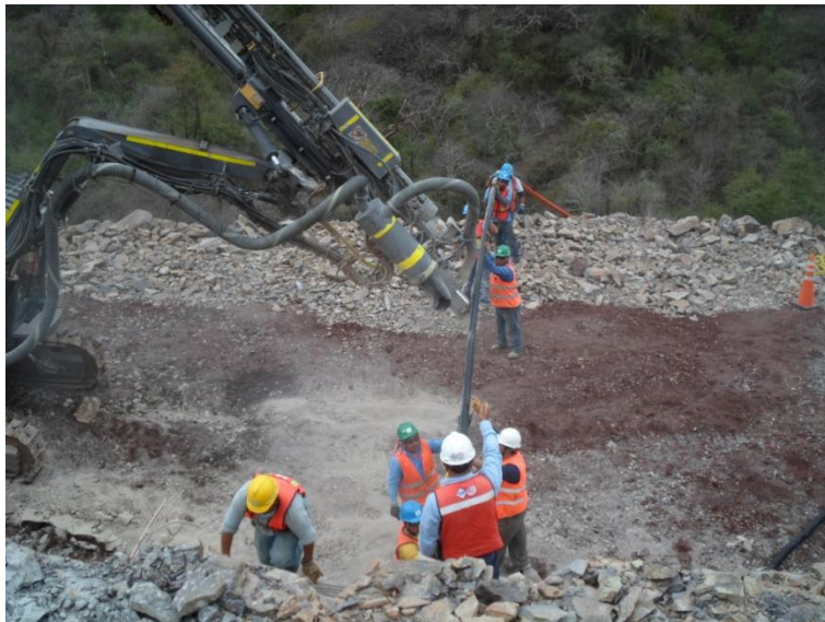
Fotografía 8. Colocación de las anclas en el talud.
