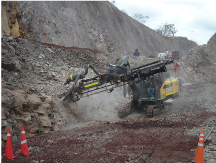
Fotografía 7. Equipo de perforación Flexi Roc con martillo a rotopercusión.
