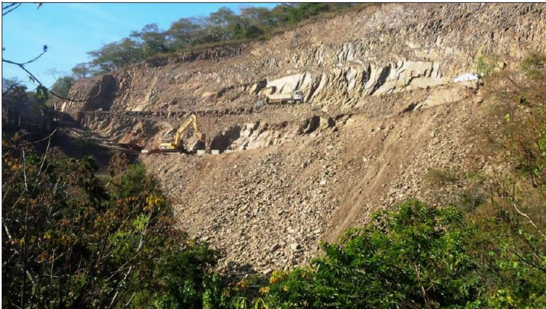
Fotografía 1. Vista del talud.
