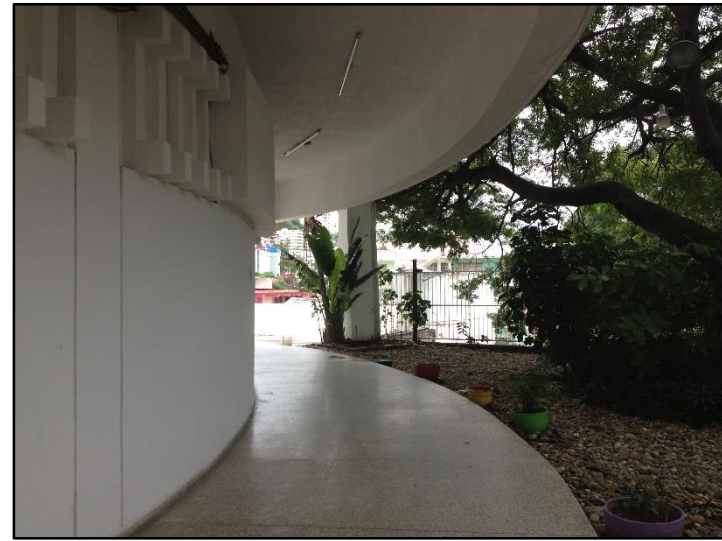
Pasillo exterior que rodea todo el perímetro del inmueble.
