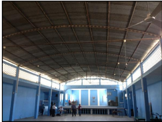
Interior del Salón Multiusos
