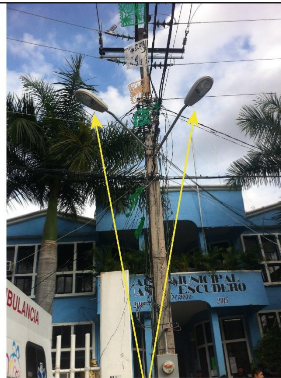
-Luminarias colocadas en postes de distribu- ción electrica aérea
