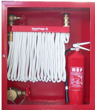
Hidrante mixto de sistema contra incendio
