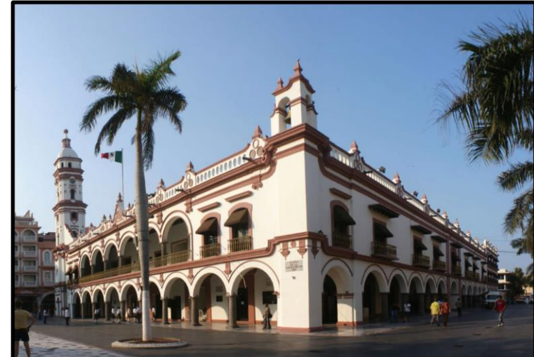
Imagen que demuestra el estado actual del primer ayuntamiento de México, en Veracruz.
