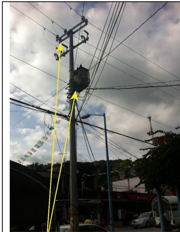
-Distribucion electrica aérea - Transformación de Luz
