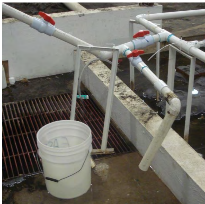
Figura 6. 16 Medición de gasto en líneas de alimentación
