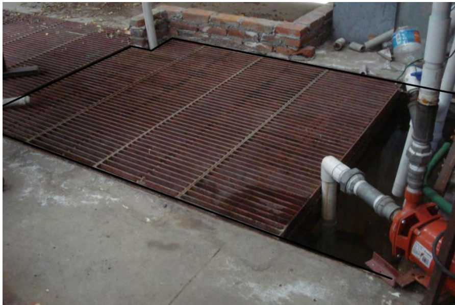
Figura 6. 1 Cárcamo de bombeo, con capacidad de 2.17 m 3
